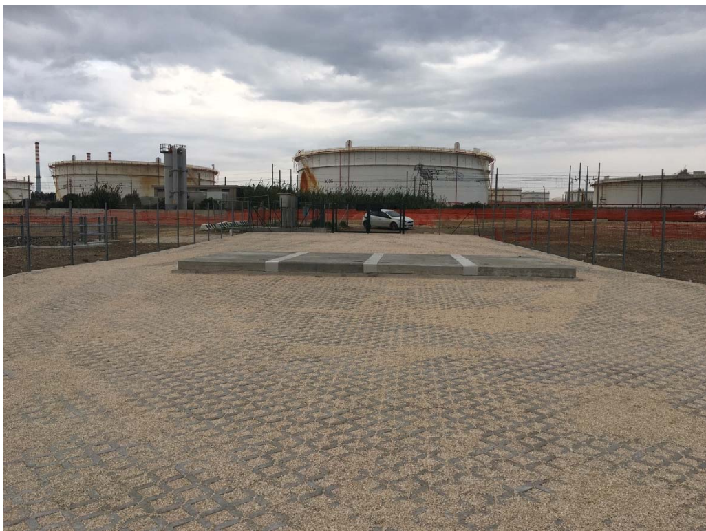
Figura 2 – Interno area punti di campionamento Scarichi A e B (vista verso strada)
