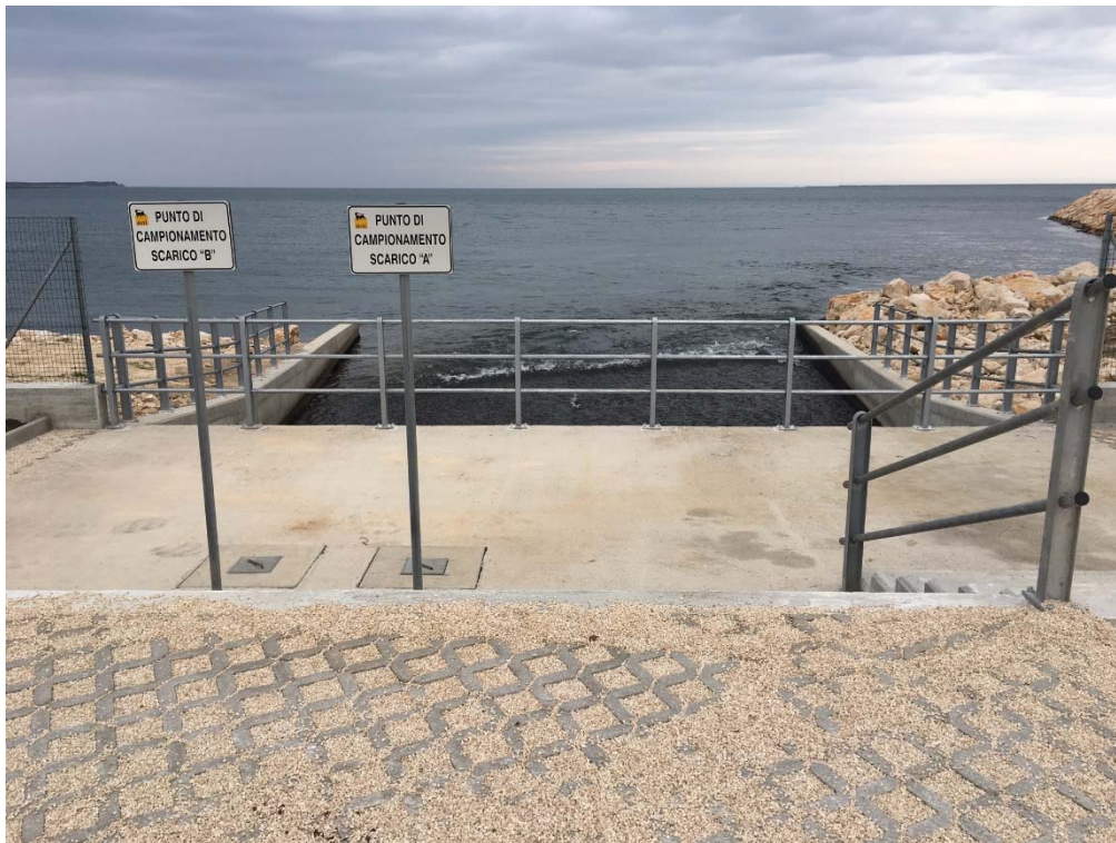
Figura 3 – Interno area verso i punti di campionamento Scarichi A e B (vista verso mare)
