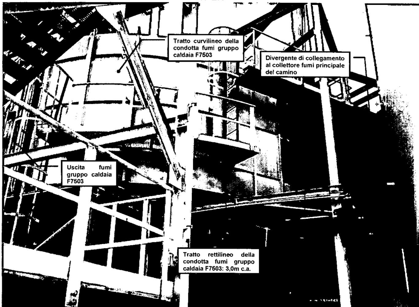
*Vista d'insieme della condotta fumi della caldaia F7503*
