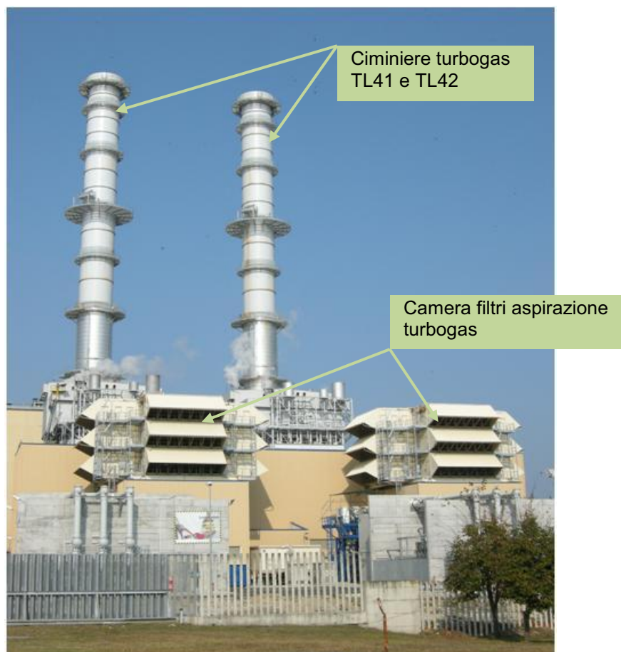
FABBRICATO TURBOGAS TL41 E TL42
