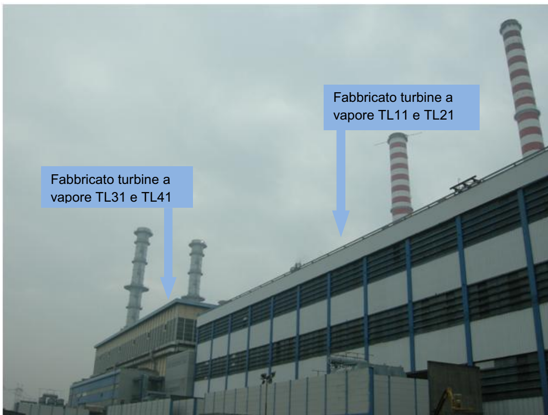
FABBRICATI TURBINE A VAPORE
