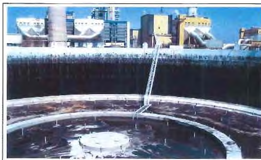
Figura 13 – Panoramica del tetto galleggiante
