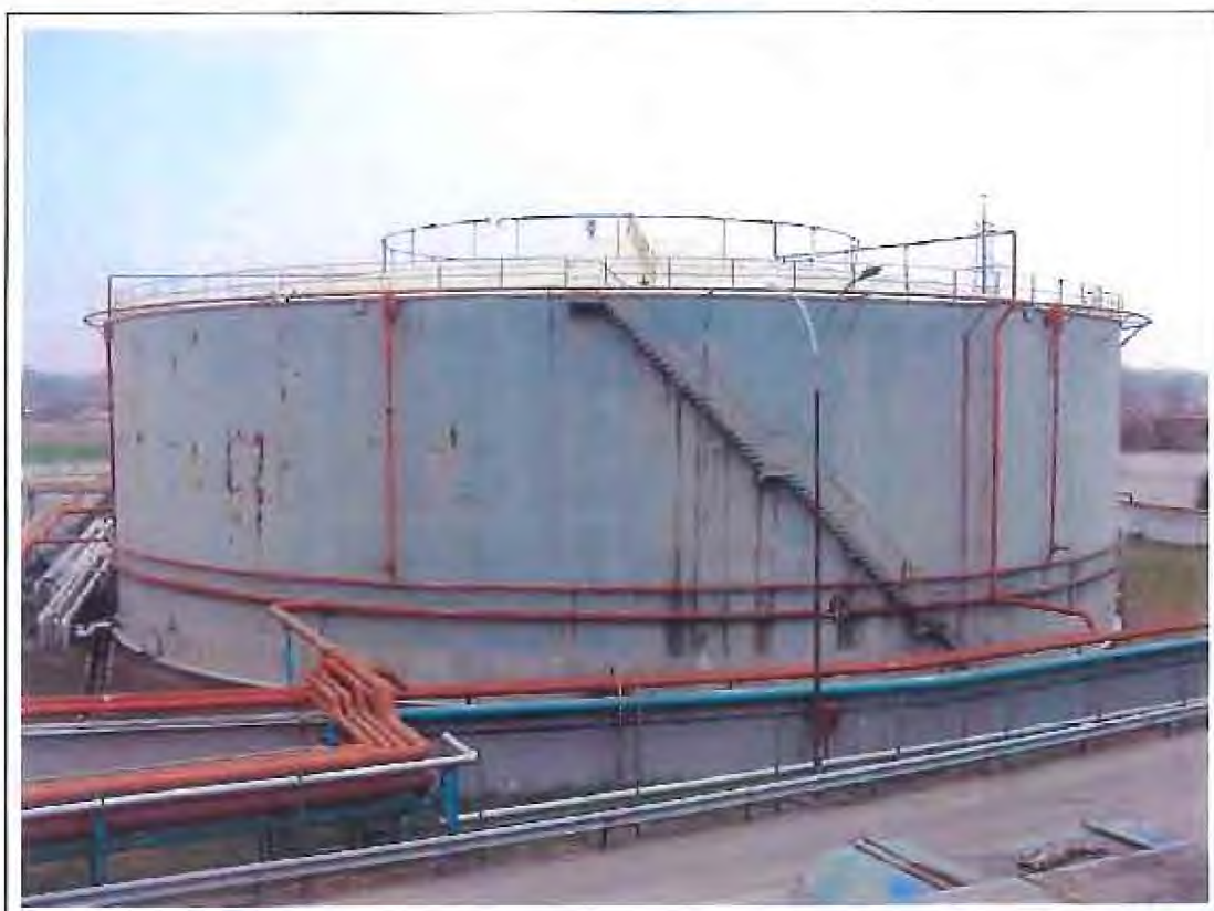
Figura 10 – Area serbatoi da 20.000 m 3
