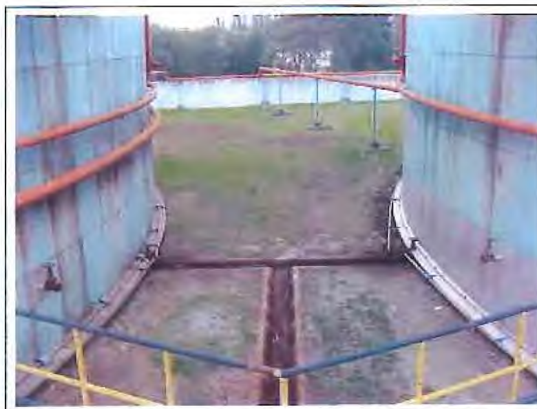
Figura 11 – Particolare delle fondazioni dei serbatoi
