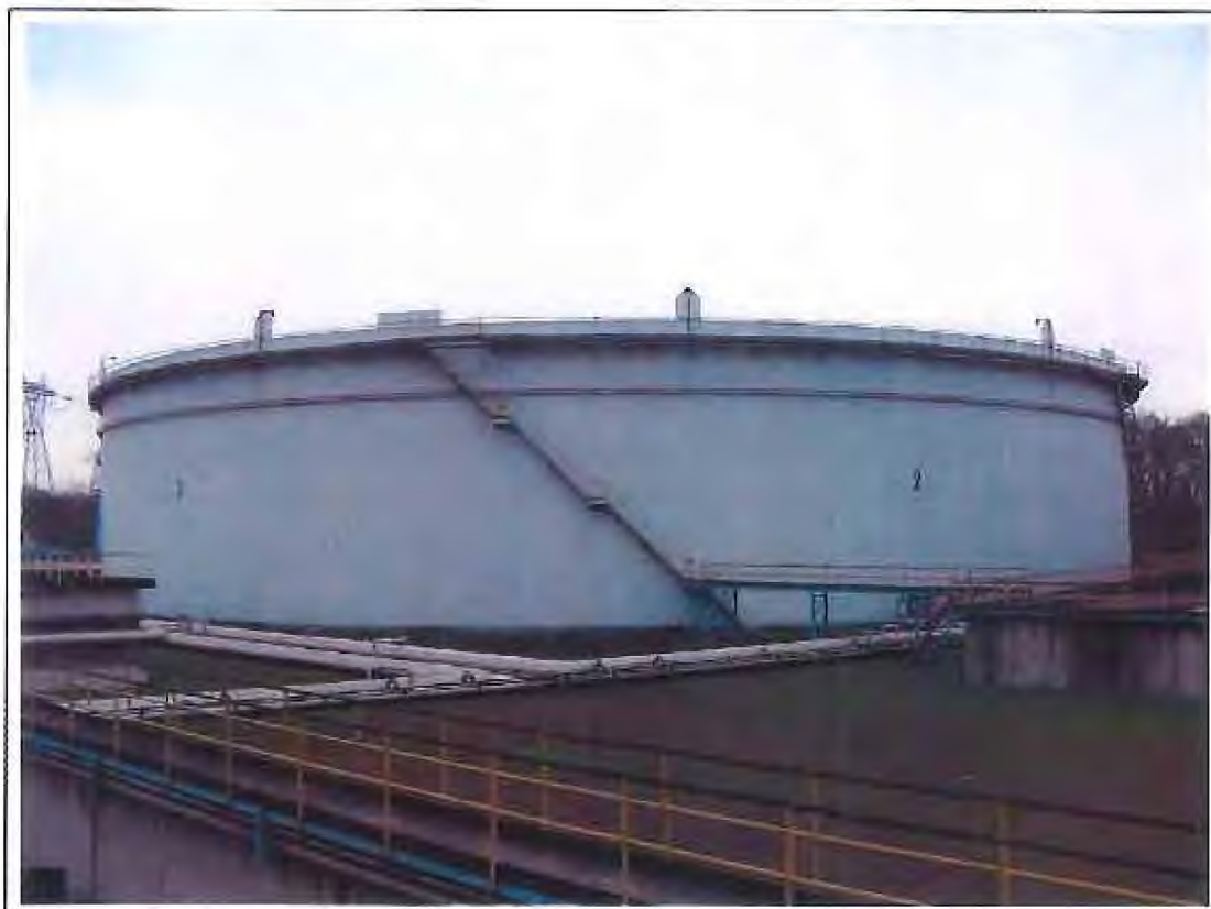
Figura 12 - Area serbatoi da 100.000 m 3
