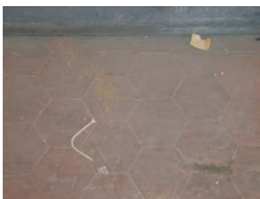
cabina 10kVSSIII sala quadri
