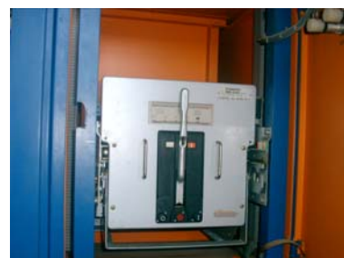
cabina 36 quadro BT tipo PC presenti 3 interruttori serie CONTROL tipo B costruttore MARINI GALILEO con sospetta presenza garza in amianto
