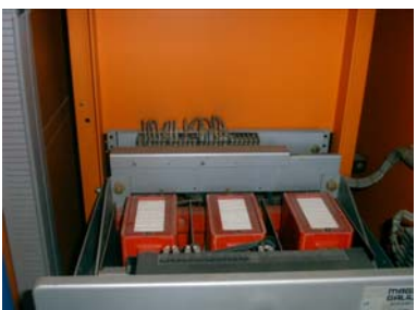
cabina 36 quadro BT tipo PC presenti 3 interruttori serie CONTROL tipo B costruttore MARINI GALILEO con sospetta presenza garza in amianto
