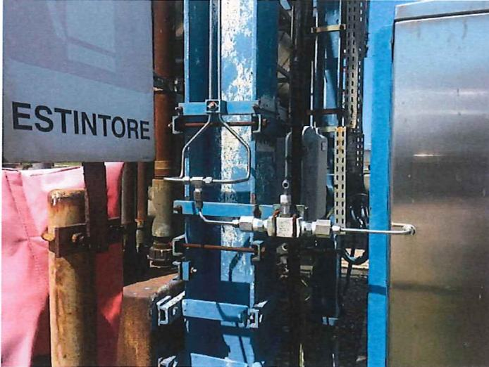
**Sistema di campionamento dopo l'inserimento del separatore di condense**
