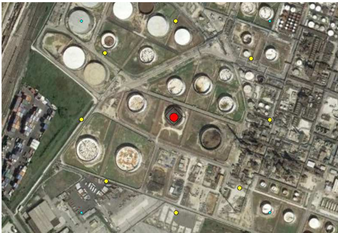
Schema di rappresentazione dei serbatoi per la calibrazione tra sorgente puntuale e areale con individuazione dei punti recettori per la calibrazione
