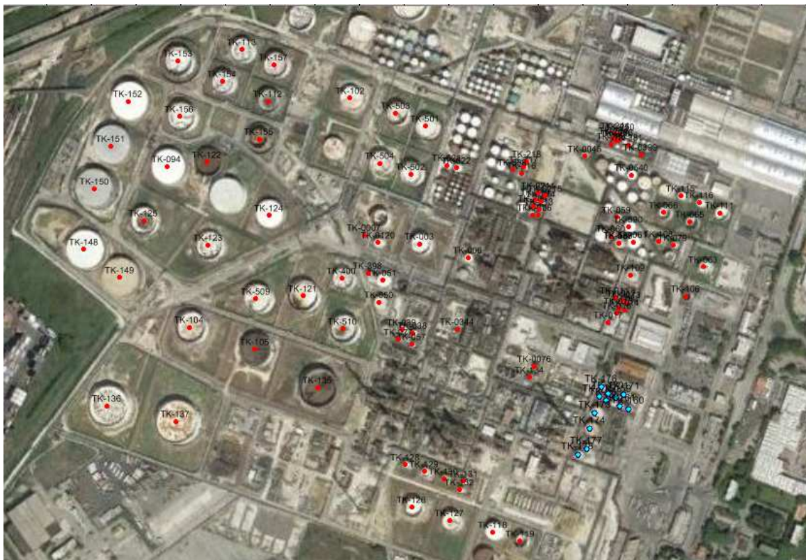
Figura 5.1: Mappa delle sorgenti con emissioni di vapori potenzialmente odorigene individuate all'interno del parco serbatoi per il presente studio.
