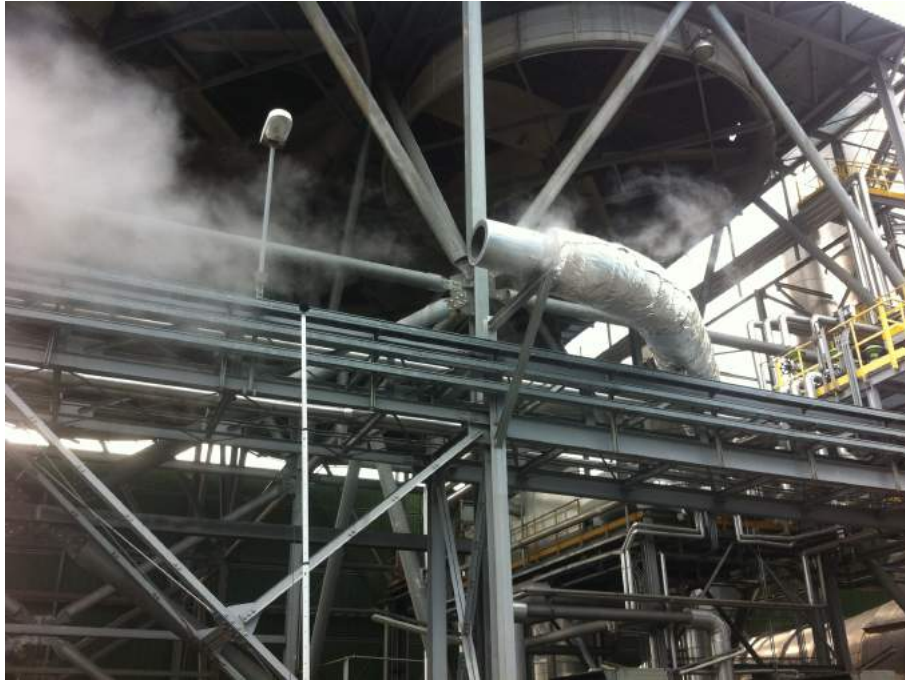
FOTO 2 –EIETTORE DI AVVIAMENTO DURANTE TEST DIURNI DI EMISSIONE SONORA IN MODALITÀ DI SOLO MANTENIMENTO (CENTRALE IN MARCIA)
