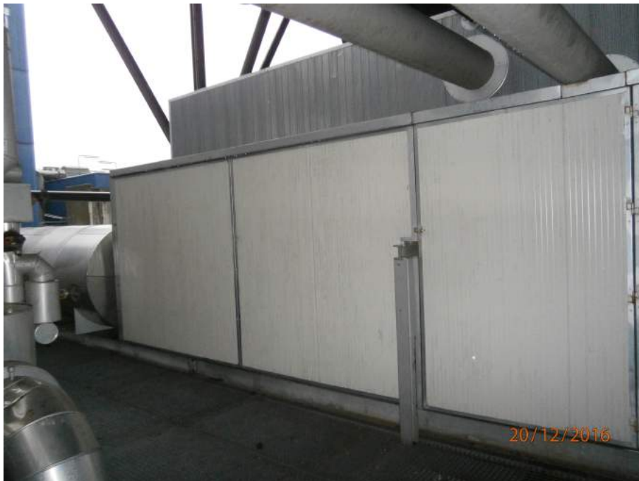
FOTO 7 – POTENZIAMENTO DEL BOX FONOISSOLANTE E FONOASSORBENTE ATTORNO ALL'EIETTORE E NUOVO SILENZIATORE SUL CONDOTTO DI ESPULSIONE
