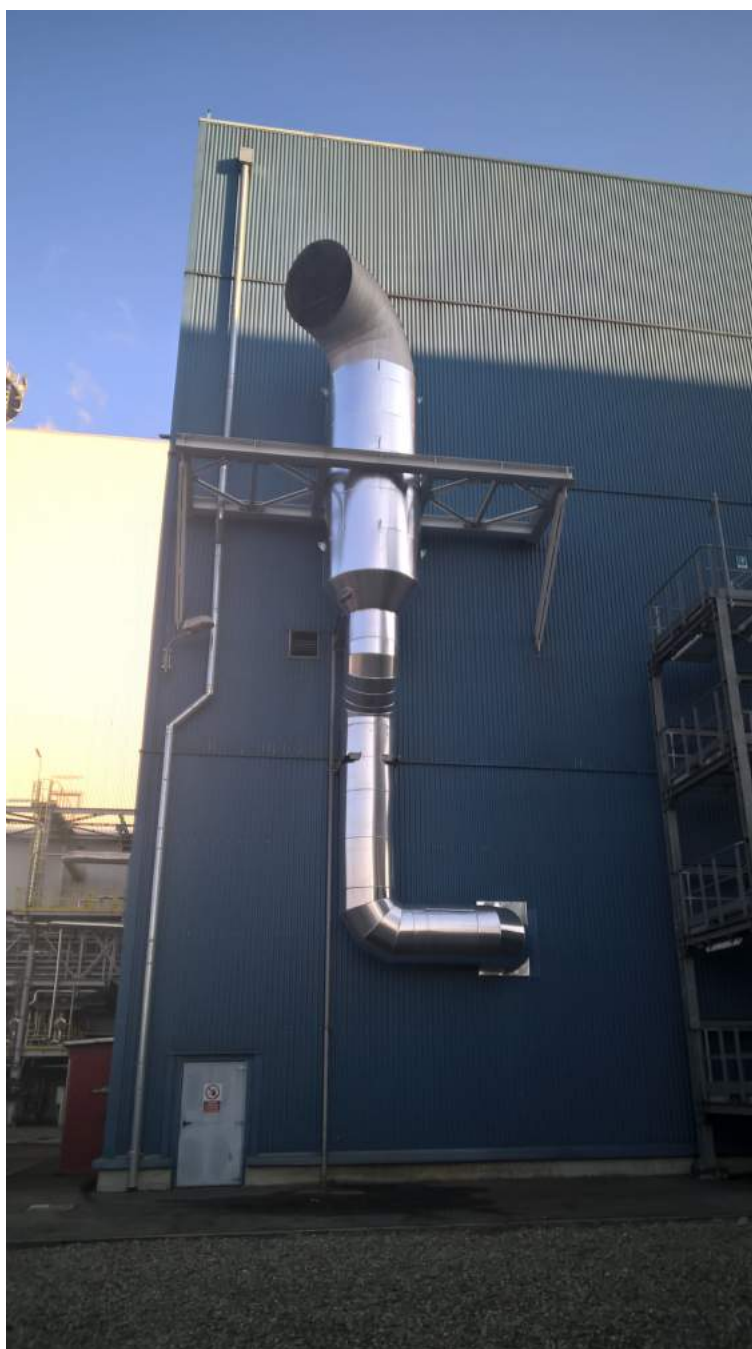
FOTO 10 -TUBO-CAMINO A LAVORI COMPLETATI
