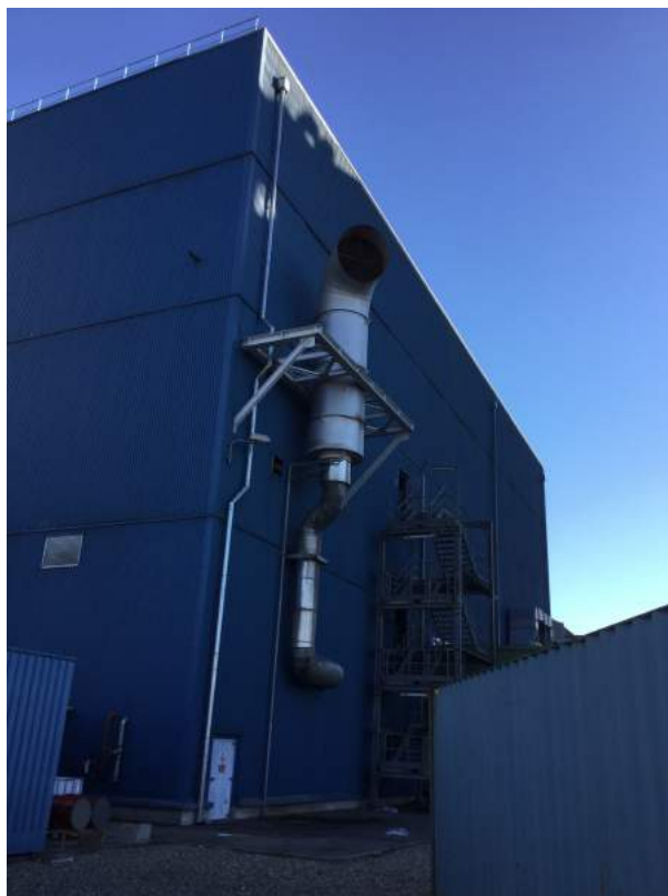
FOTO 4 – TUBO-CAMINO CON SILENZIATORE ALLO SBOCCO (IL TUBO NON ERA COIBENTATO NEL TRATTO TRA EDIFICIO E SILENZIATORE)
