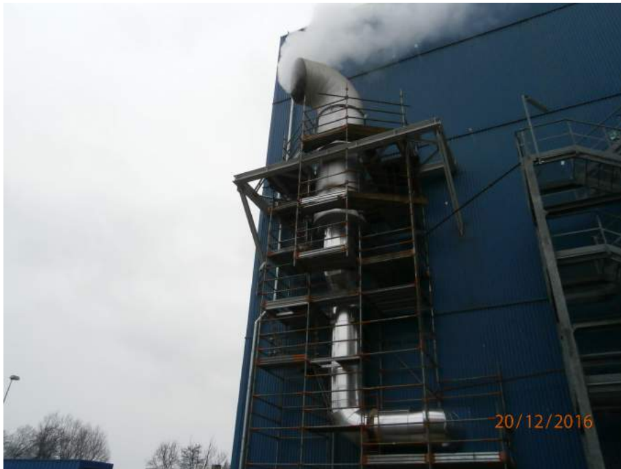
FOTO 9 – LAVORI DI COIBENTAZIONE DEL TUBO-CAMINO (PARTICOLARE)
