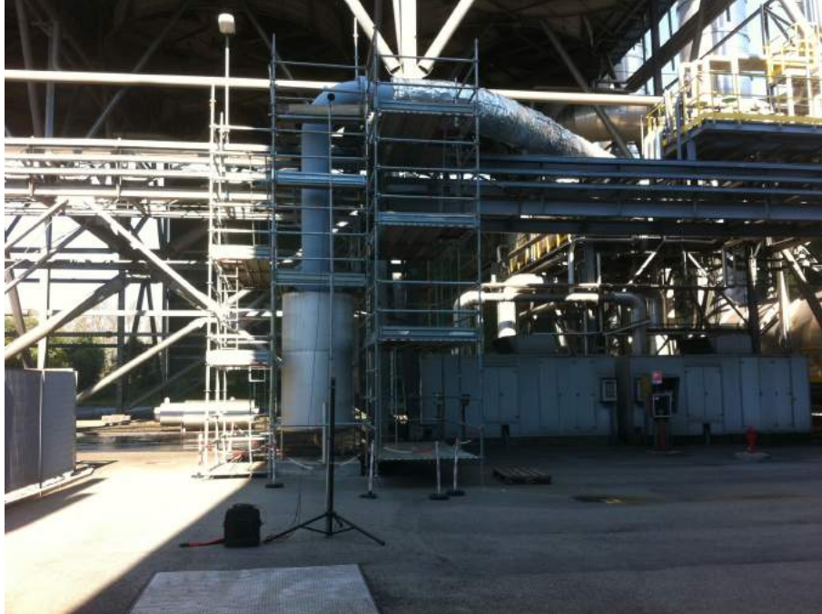
FOTO 7 – POTENZIAMENTO DEL BOX FONOISSOLANTE E FONOASSORBENTE ATTORNO ALL'EIETTORE E NUOVO SILENZIATORE SUL CONDOTTO DI ESPULSIONE
