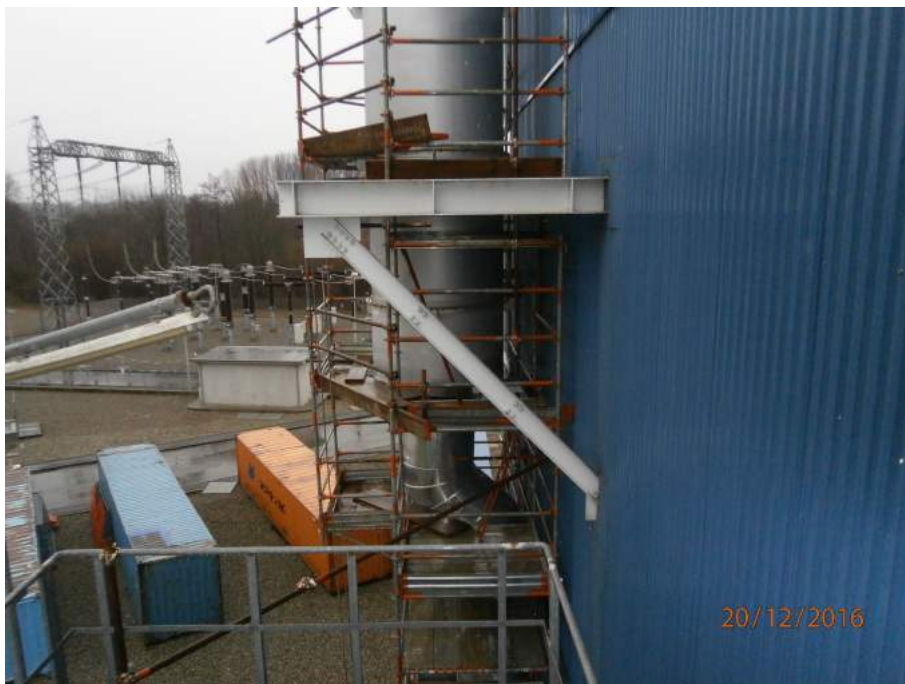
FOTO 9 – LAVORI DI COIBENTAZIONE DEL TUBO-CAMINO (PARTICOLARE)
