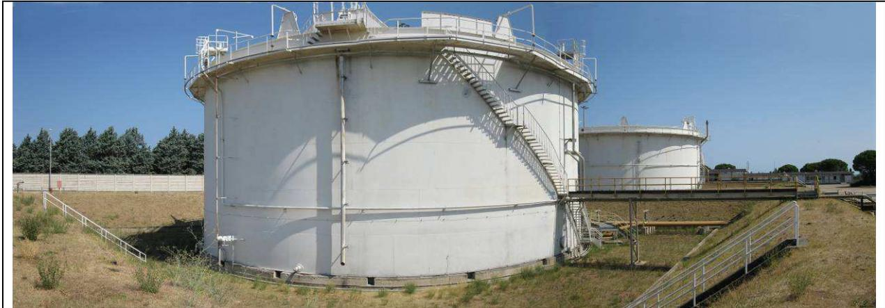
**Figura 2** - Serbatoi di stoccaggio e relativo bacino di contenimento
