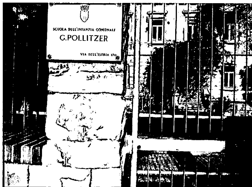
Fig. 23 – Via dell'Istria – Scuola dell'infanzia – vista esterna
