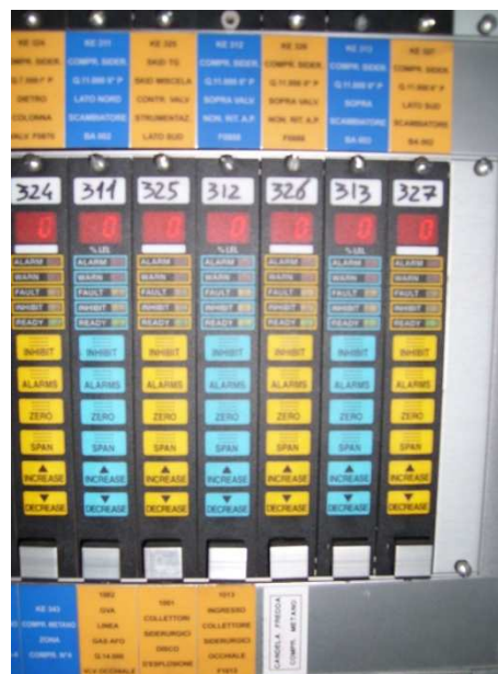
Figura 1 – schede a cui confluiscono i segnali: in giallo quelle per il CO, in azzurro quelle per il CH 4
