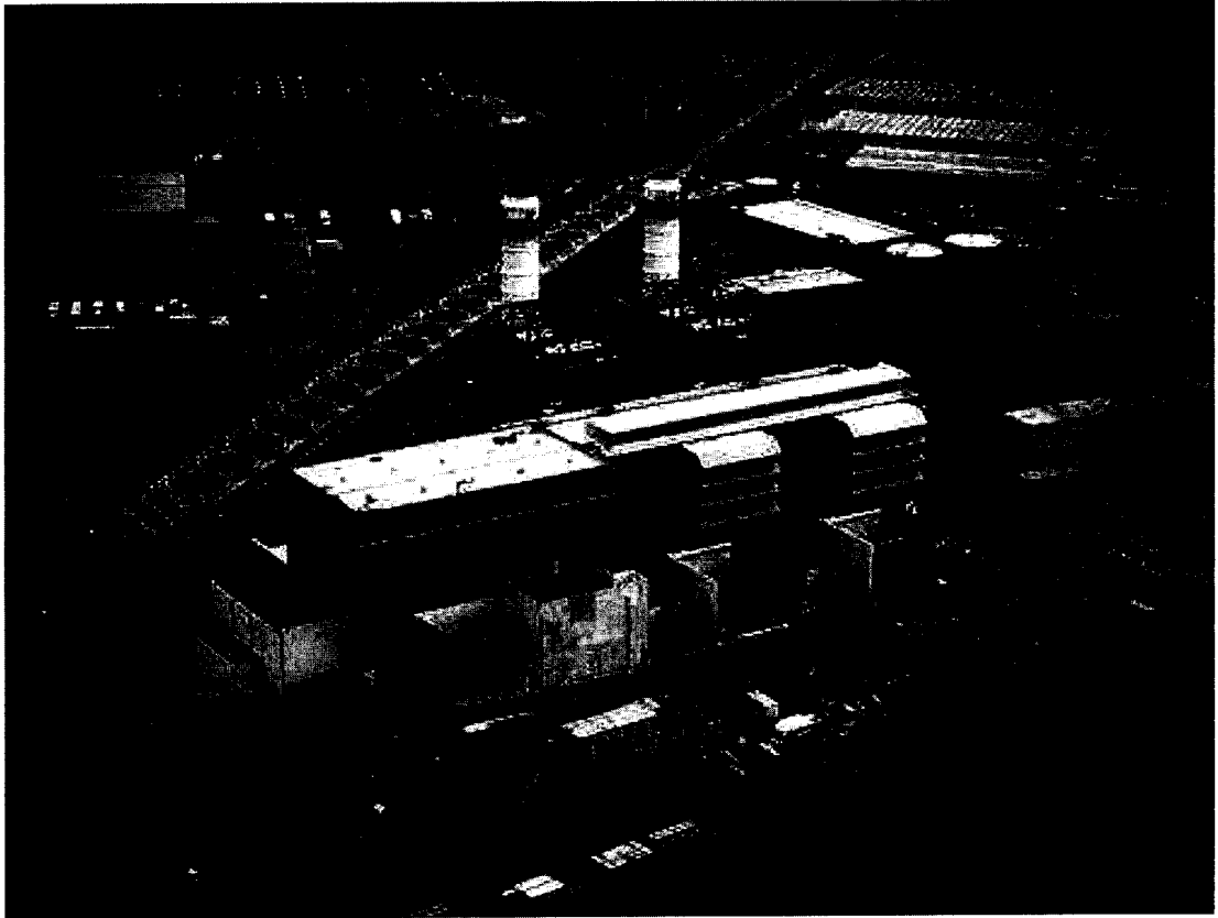
Figura 2: Immagine Impianto SORGENIA Puglia Spa di Modugno
