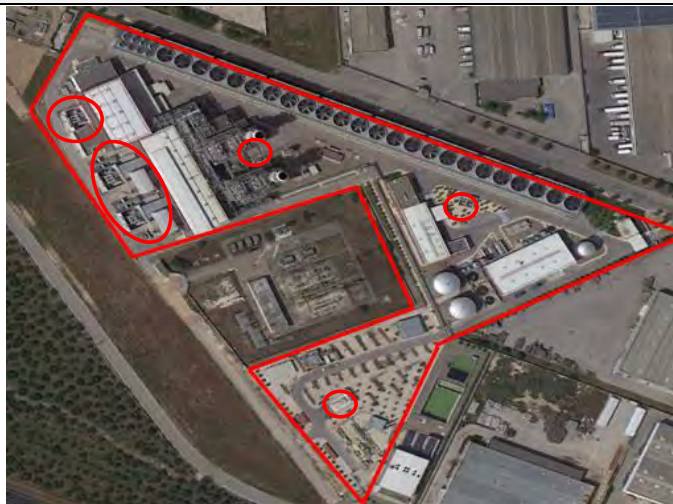
Rilievo fotografico - Trafo Step Up (15/380 KV)
