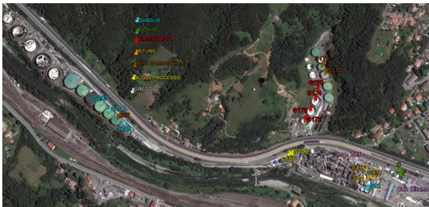
Figura 1.5-1 – Dominio emmissivo: serbatoi, impianto zolfo e carico bitume.
