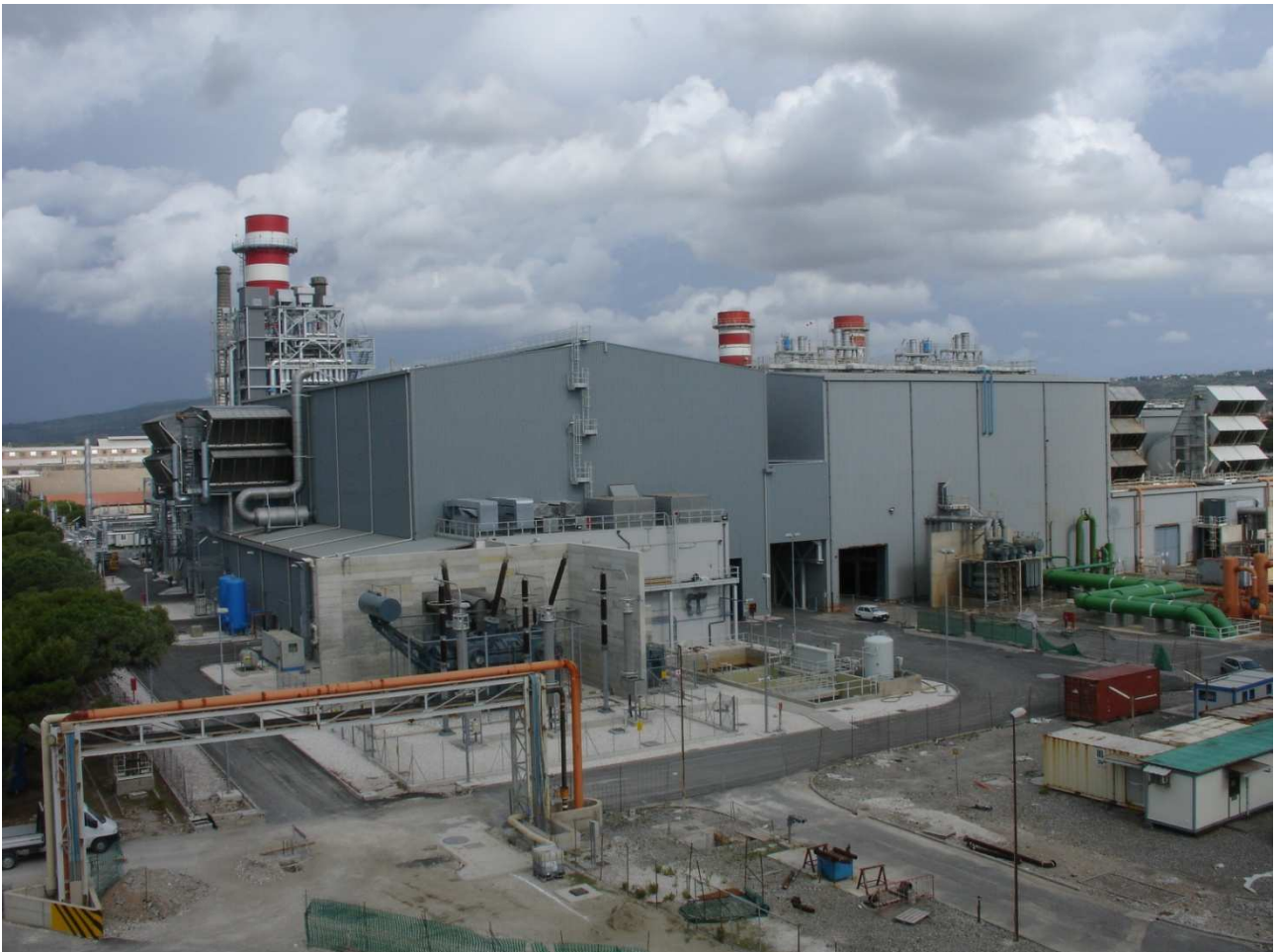
Centrale lato Sud
