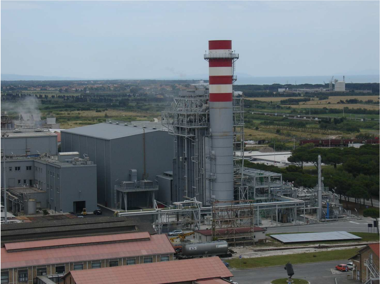
Centrale lato Nord
