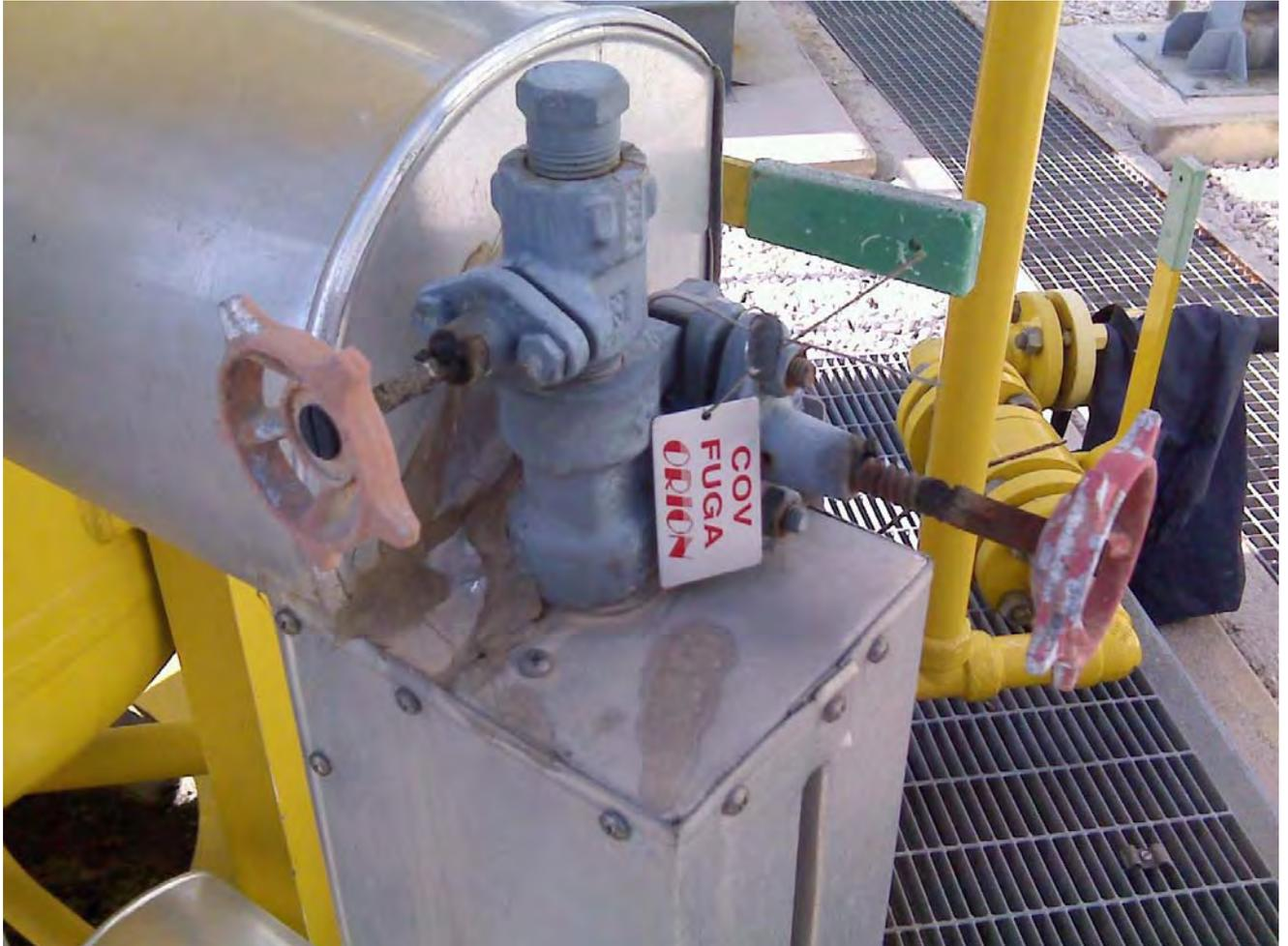
**Riduzione della perdita a seguito di intervento di riparazione in data 28/03/2014.**
