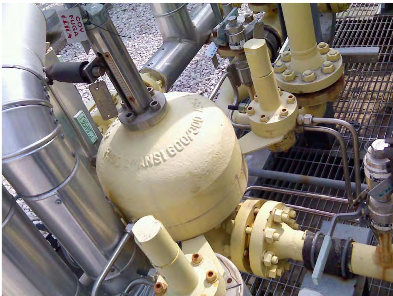
Inoltre si segnala che a seguito degli interventi eseguiti il 13-04-15 , dei tecnici meccanici presenti in centrale , è rientrata sotto soglia la perdita rilevata sul gruppo valvole del livellostato 10EKE12AT001 numero tag 1594. La misura dopo la riparazione è di 2880 ppmV
