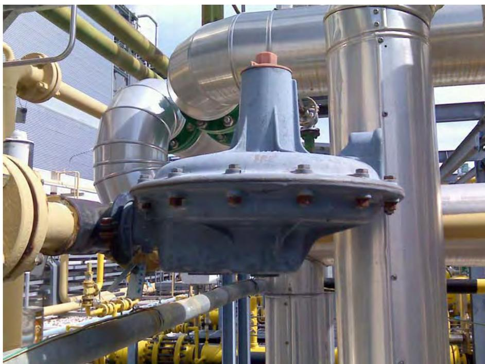
3) DA RIDUTTORE DI PRESSIONE DELLA LINEA 10EKG33BR012 , INVIO FUEL GAS A HEATING WATER BOILER 10EKT12AV001
