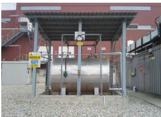
Rilievo fotografico - gasolio generatore d'emergenza
