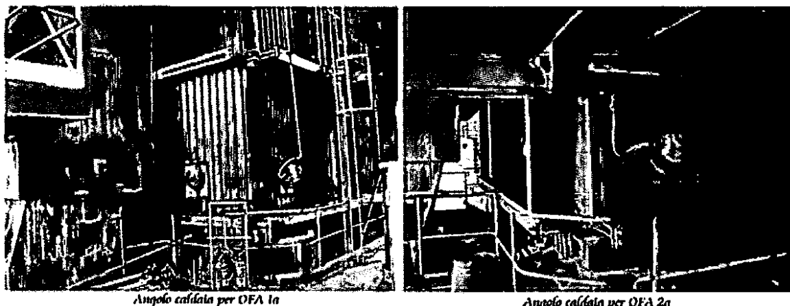
Fig. 8 – Posizione delle attuali portine di ispezione al posto delle quali saranno installate le porte SOFA
