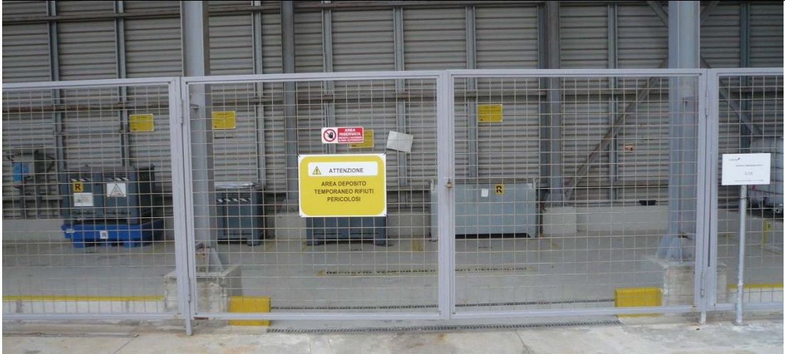
Area deposito temporaneo rifiuti pericolosi
