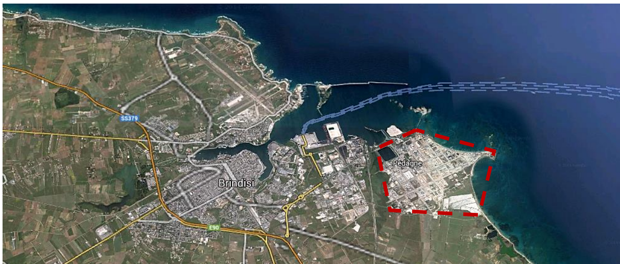
Figura 2-1. Localizzazione dell'impianto Versalis S.p.A. (tratteggio rosso) affianco all'abitato di Brindisi
