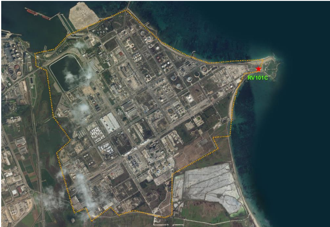
Figura 23. Localizzazione della torcia RV-101C dell'impianto Versalis
