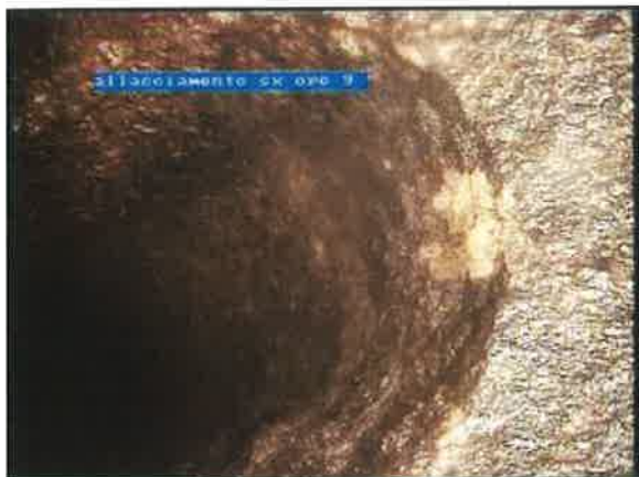
Foto: 172a, Video: MH9-MH2 13,9m, Allacciamento, ore09
