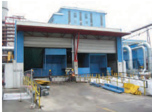
Figura 3 - Zona di ingresso del capannone
