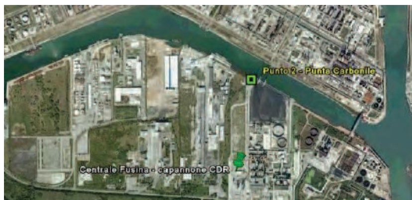
Figura 11 - Punto 2 - Tetto di edificio accanto al carbonile della centrale
