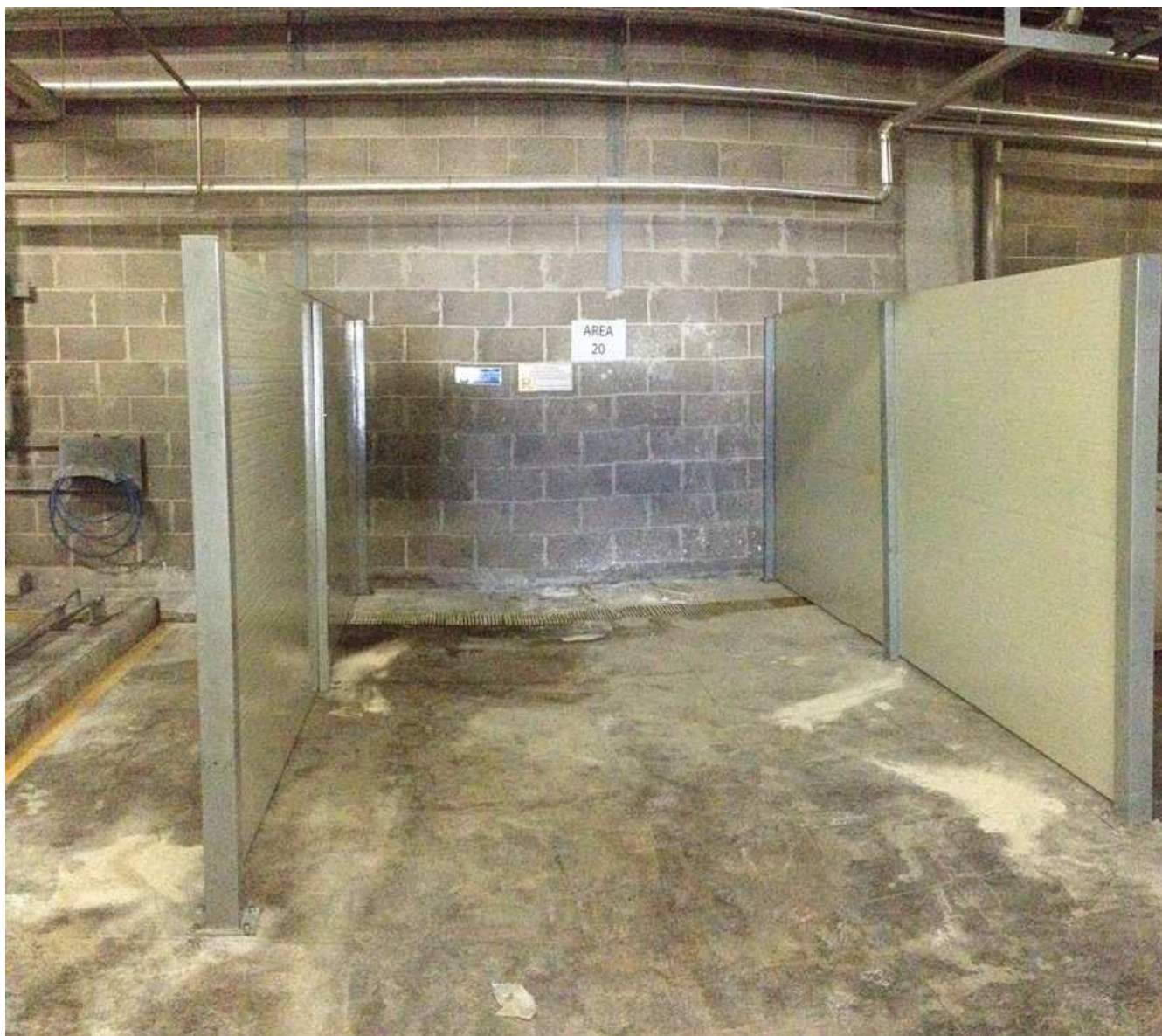
Realizzate pareti divisorie in aggiunta alla delimitazione definita dai sacconi, aggiunto cartello di identificazione area in aggiunta al cartello identificazione rifiuti.
