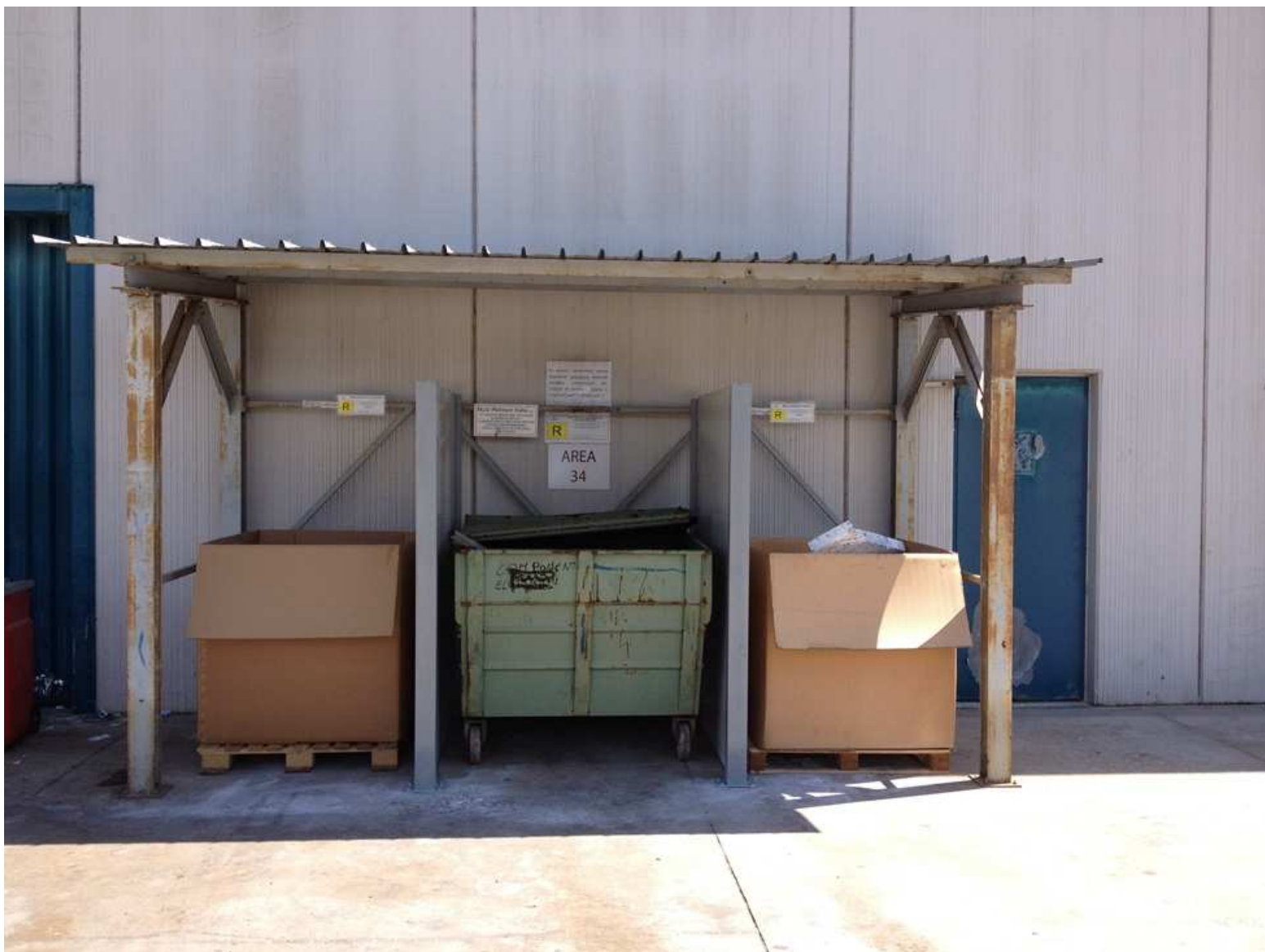
Realizzate pareti divisorie in aggiunta alla delimitazione definita dai contenitori, aggiunto cartello di identificazione area in aggiunta ai cartelli identificazione rifiuti.
