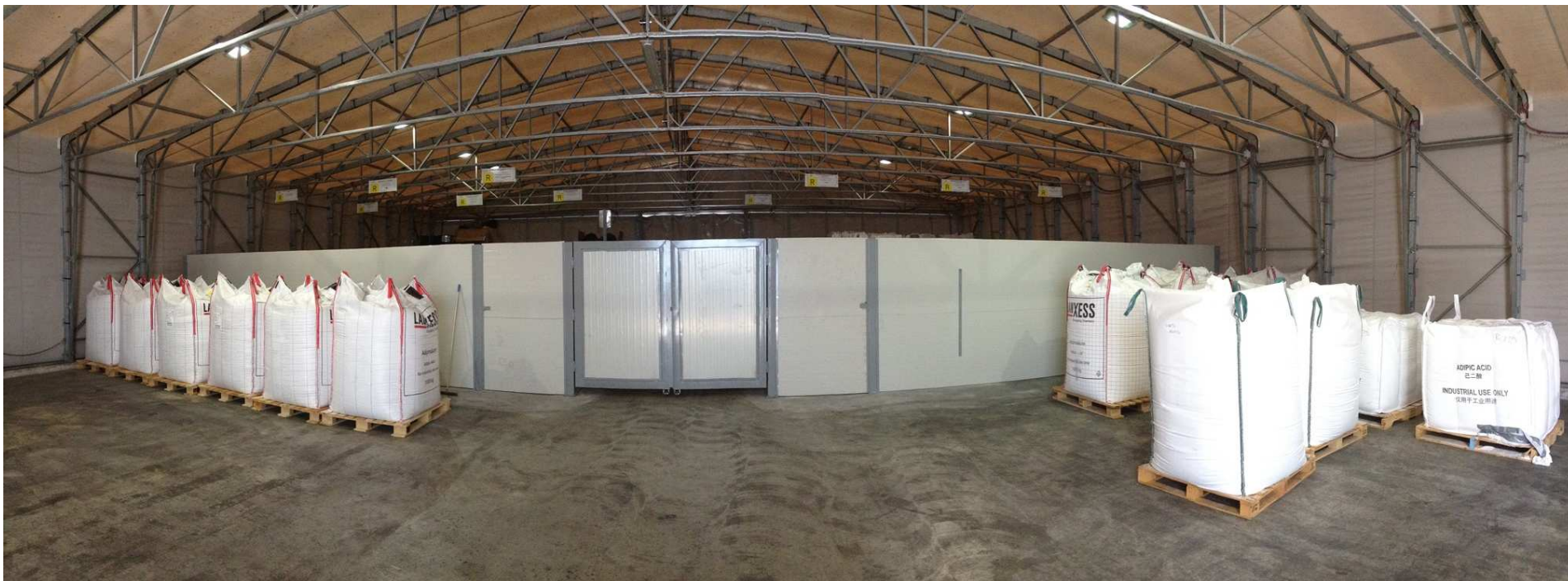
Realizzata delimitazione fisica in aggiunta all'esistente delimitazione realizzata tramite segnaletica a terra.
