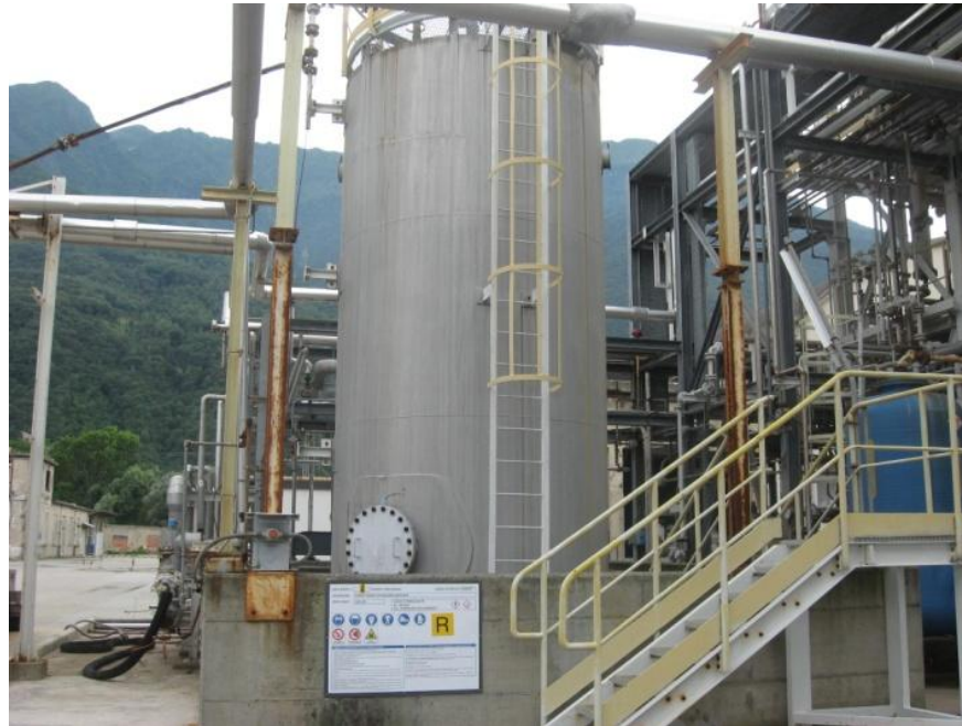
Fig. 19 Area 4 Serbatoio T7266.
