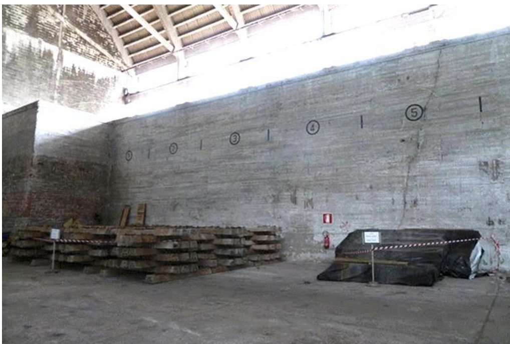
Fig. 8 Visione complessiva dell'area di stoccaggio del materiale da utilizzare, presso il Magazzino Lauro
