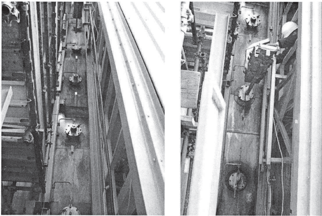
Figura 14 Vista dei bocchelli e simulazione dell'accostamento del carrello per l'inserimento della sonda di campionamento in uno dei bocchelli (non presente sonda avente lunghezza circa 4 m)
