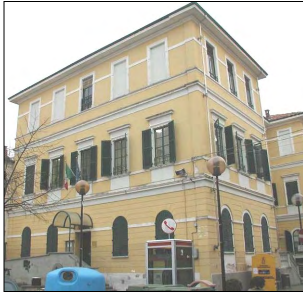
Figura 3.10 – Scuola elementare “C. Collodi” a Caselle T.se
