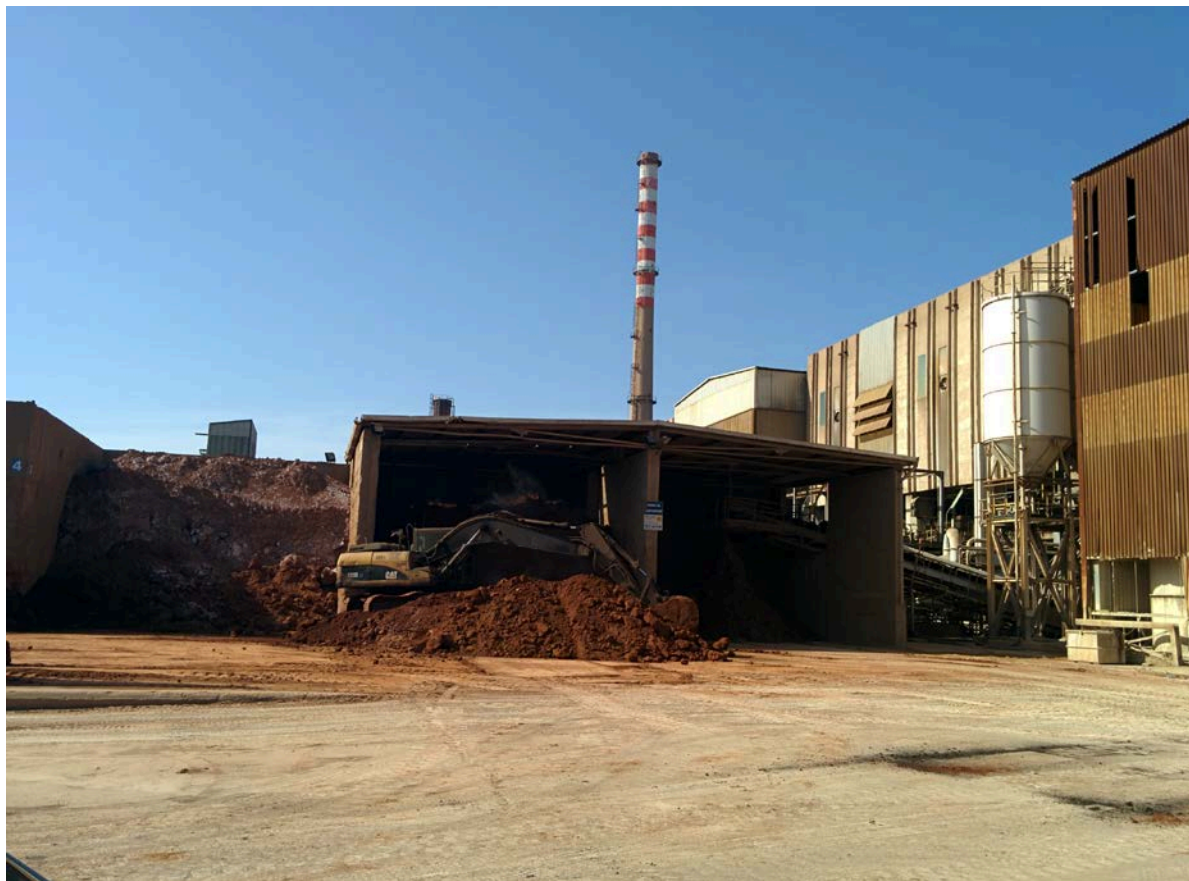
Foto 10 (sopra) del 06-10-15 deposito area n. 4 dei fanghi di conversione dal reparto lisciviazione dell'Impianto Elettrolitico – stalli coperti e stalli scoperti.
