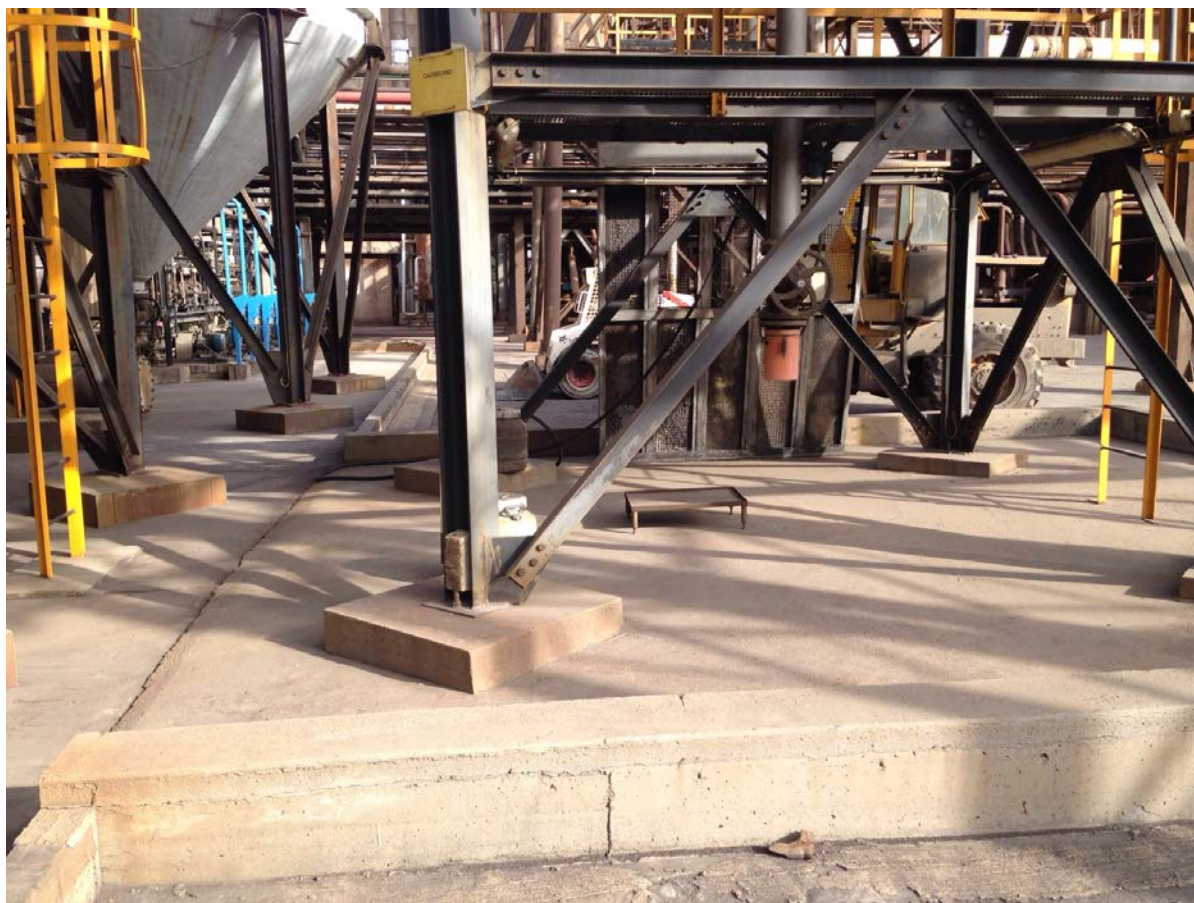
Foto 14 (sopra) del 06-10-15 area produzione di Calomelano – cordolatura su tre lati ed evidenza del lato non cordolato a sinistra della foto.
