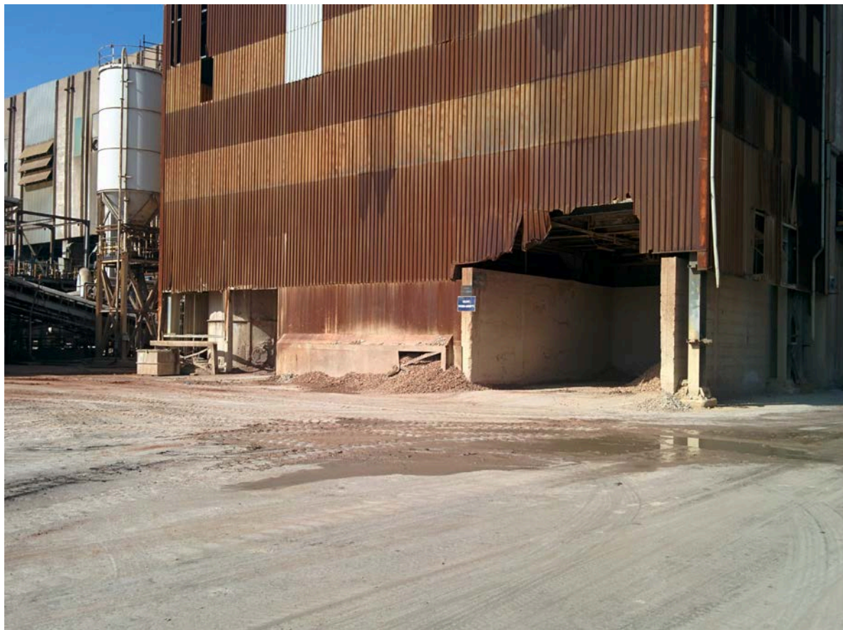
Foto 12 (sopra) del 06-10-15 stoccaggio coperto di solfati di piombo argento - materiale fuori dell'area adibita allo stoccaggio.
