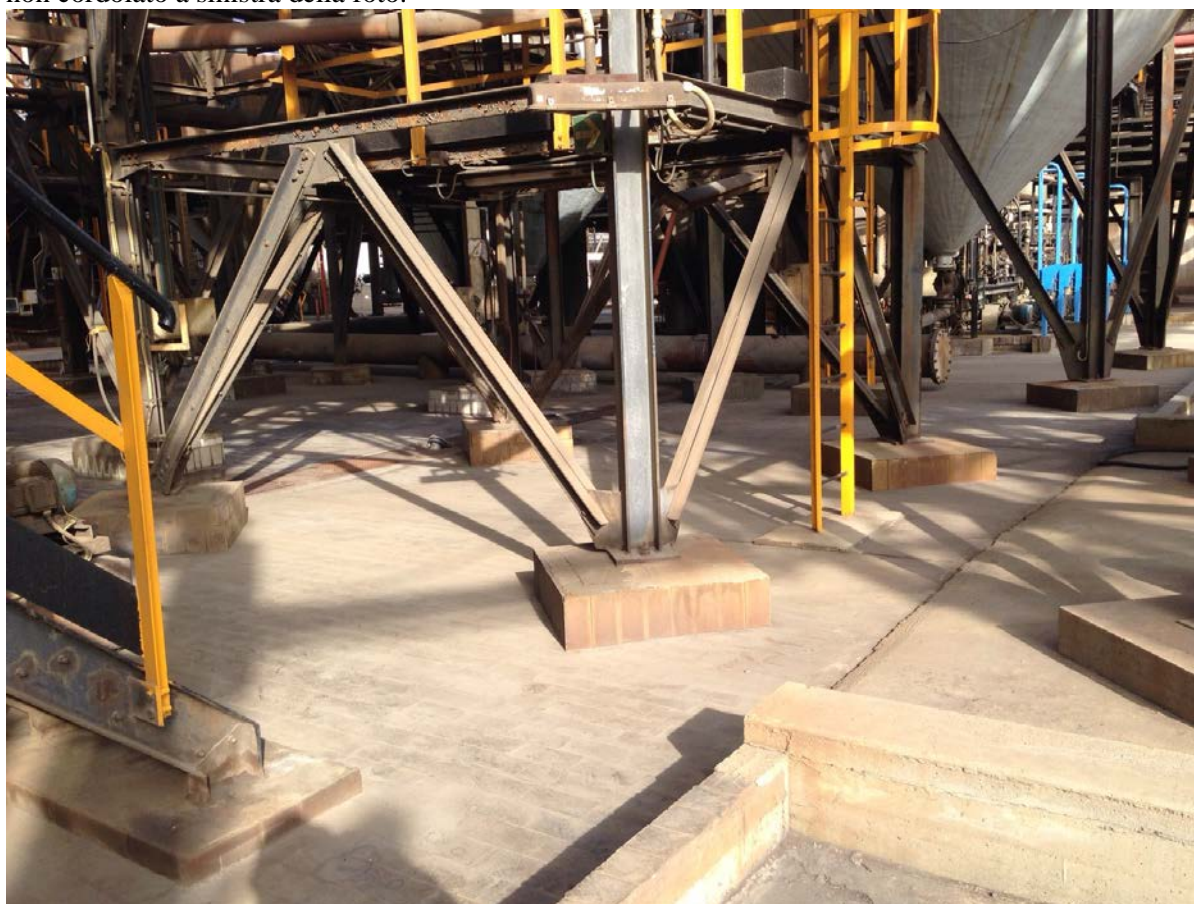
Foto 15 (sopra) del 06-10-15 area produzione di Calomelano - evidenza del lato non cordolato a destra della foto e della griglia di raccolta delle acque a sinistra della foto.
