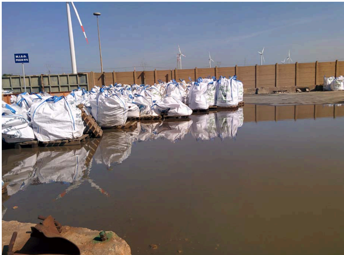
Foto 8 (sopra) del 06-10-15 area di deposito temporaneo presso Area vasche ex ENI Risorse – acqua stagnante a causa di un tombino intasato.
