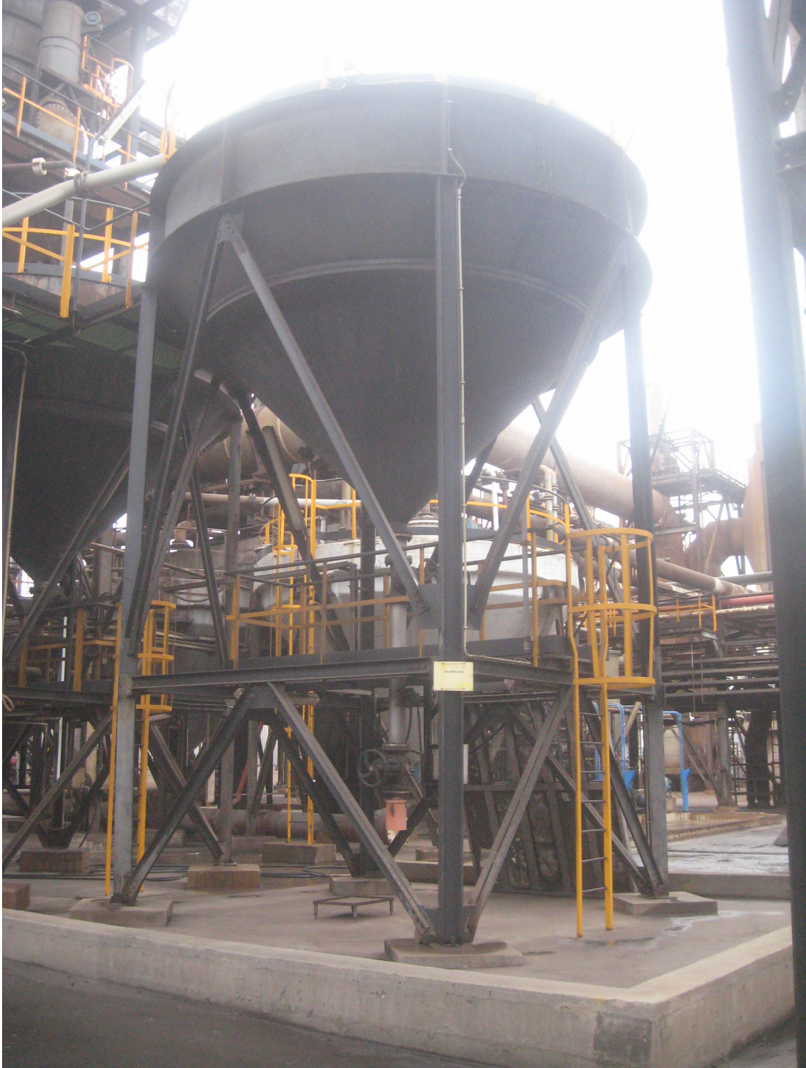
Vista d'insieme del bacino di contenimento da completare
