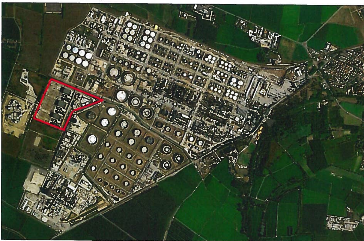
Figura 2: Centrale enipower Ferrera Erbognone (PV)
