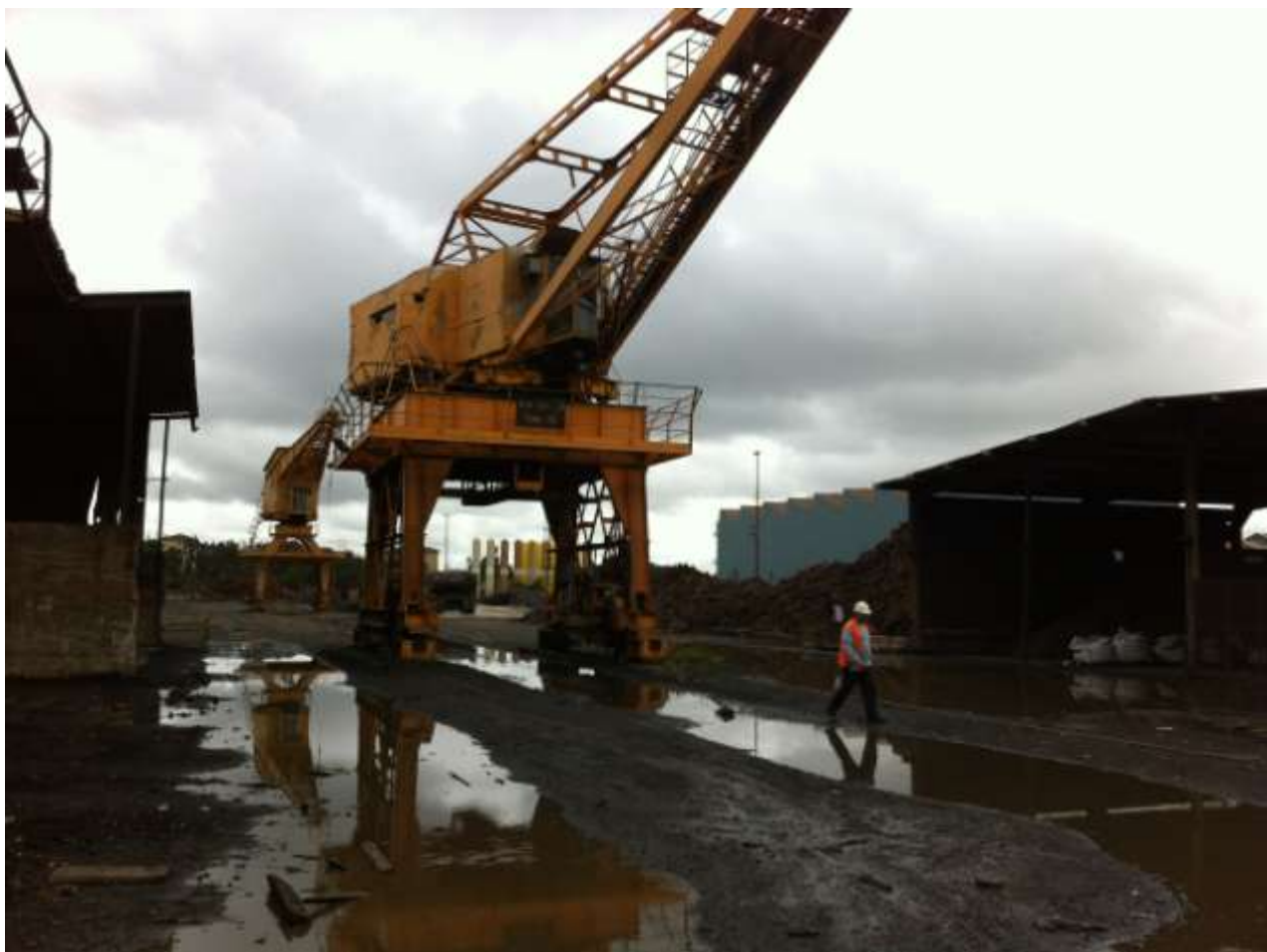
Foto 3 del 26-03-15 area stoccaggio rottami - mancanza di deflusso e convogliamento delle acque di dilavamento
