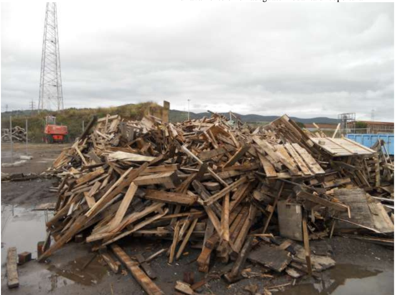
Foto 6 del 26-03-15 area n.6 di deposito temporaneo di rifiuti – mancanza di convogliamento delle acque di dilavamento e non adeguate modalità di copertura
