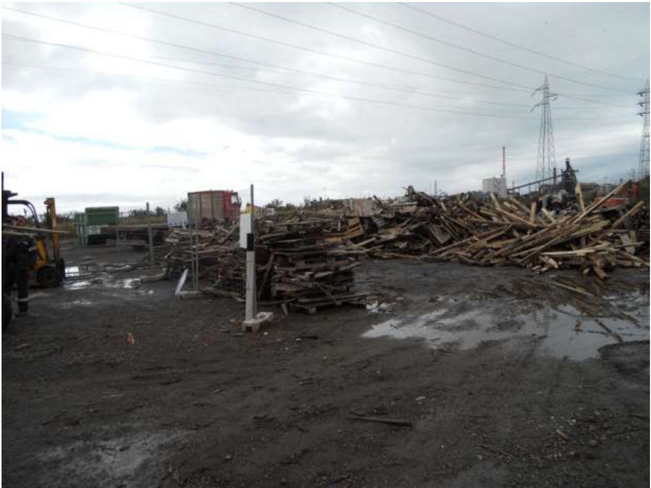
Foto 7 del 26-03-15 area n.6 di deposito temporaneo di rifiuti – non adeguata separazione delle materie prime dal deposito rifiuti
