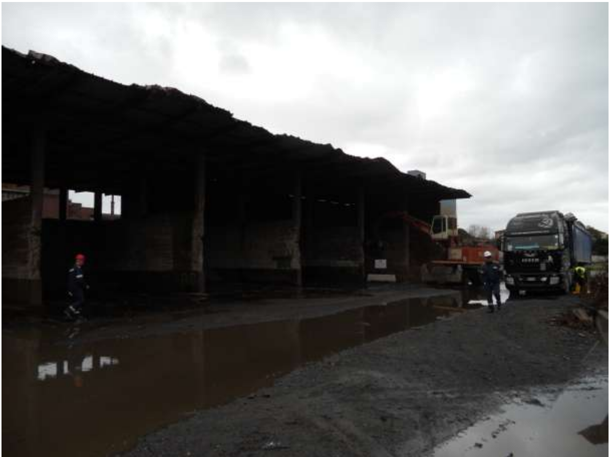
Foto 1 del 26-03-15 area stoccaggio rottami – mancanza di deflusso e convogliamento delle acque di dilavamento di fronte ai box di stoccaggio
