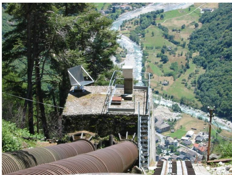
Figura 27: Riflettori artificiali (di tipo diedro rettangolare) per il monitoraggio della stabilità di una struttura (condotta forzata) in ambiente montuoso.
