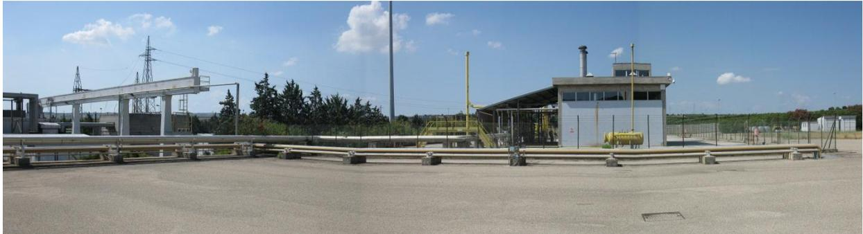
Figura 5 – Pipe-rack sopraelevato per il trasferimento del combustibile
