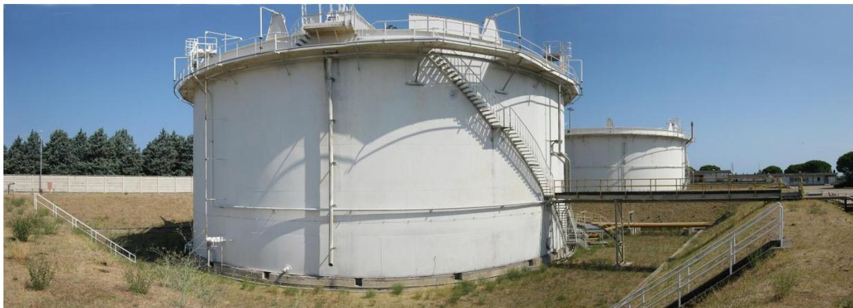
**Figura 3** - Serbatoi di stoccaggio e relativo bacino di contenimento
