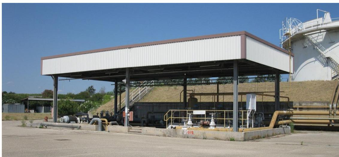
**Figura 4** - Tettoia pompe trasferimento gasolio
