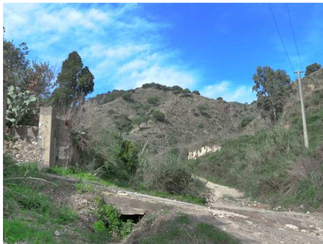
Figura 3.47 Fiumara Annunziata vista verso monte.
