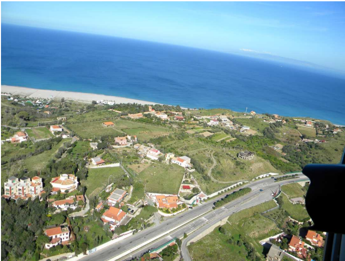
Figura 3.16 Foto da elicottero dell'area di cantiere
