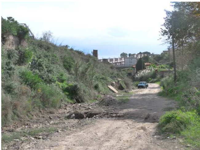
Figura 3.46 Fiumara Annunziata vista verso valle.
