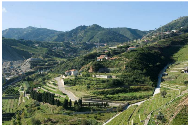
Figura 3.28 Imbocco nord galleria Faro.
