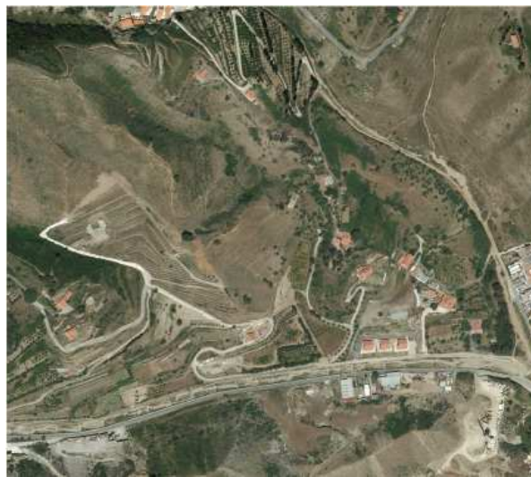
Figura 3.24 Foto aerea dell'area di cantiere.
