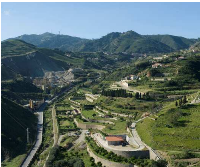
Figura 3.23 Foto da elicottero dell'area di cantiere.
