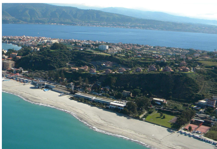
Figura 3.9 Versante del blocco di ancoraggio – ripresa dall'elicottero.
