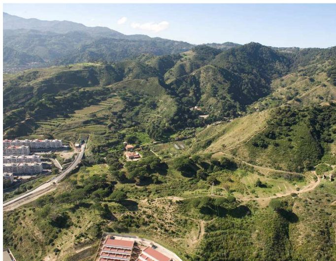
Figura 3.44 Foto da elicottero dell'area di cantiere
