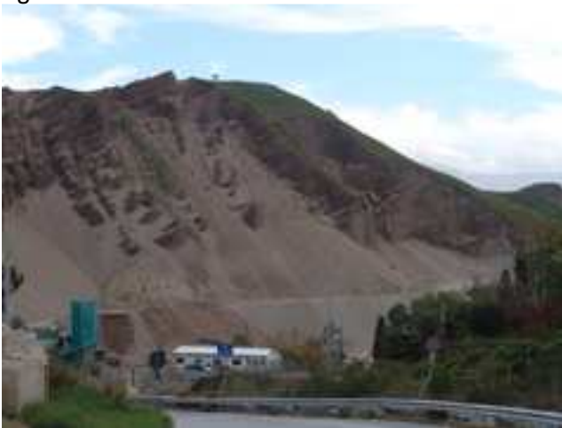
Figura 3.75 Foto del sito dalla via Fiumara.
