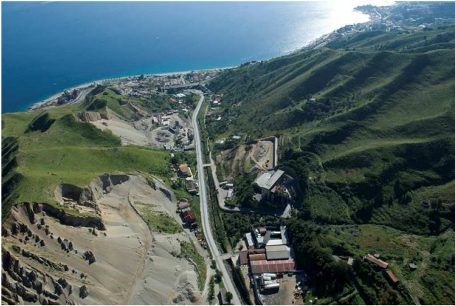
Figura 3.37 Vista da elicottero dell'area di cantiere.
