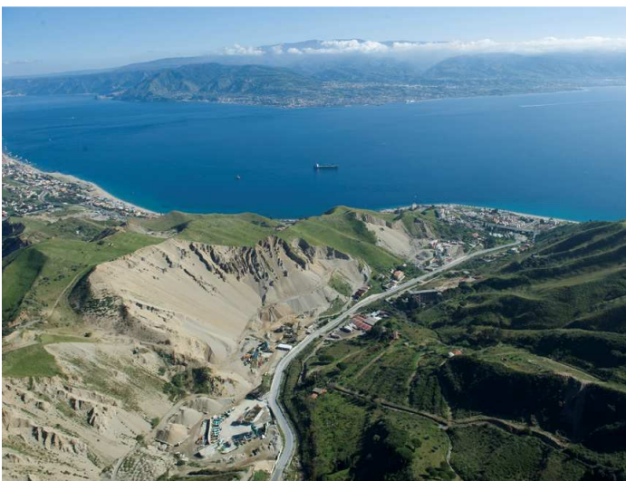
Figura 3.73 Foto da elicottero del sito.
