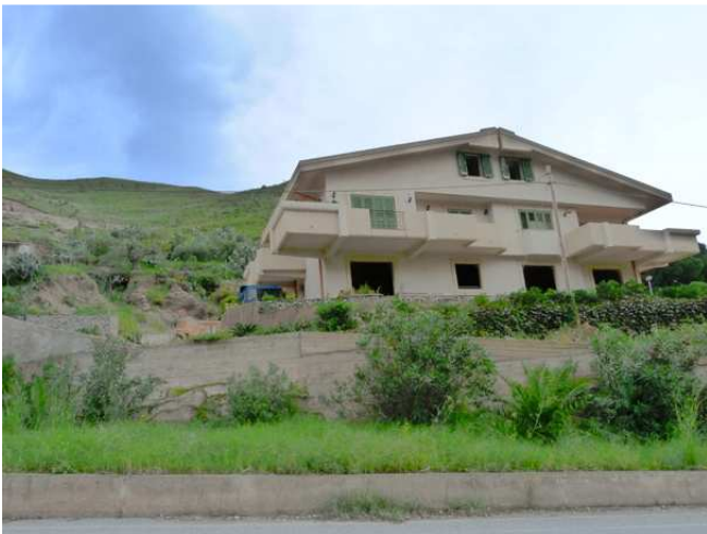
Figura 3.39 Edificio isolato lungo la strada della Fiumara Pace.
