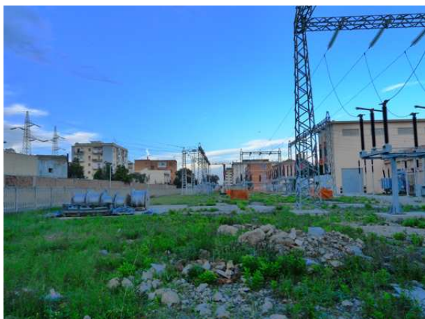
Figura 3.59 Area dell'attuale sottostazione elettrica.
