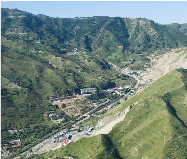
Figura 3.35 Foto da elicottero dell'area di cantiere.
