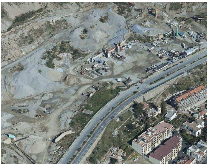
Figura 3.64 Vista aerea dell'area di cantiere
