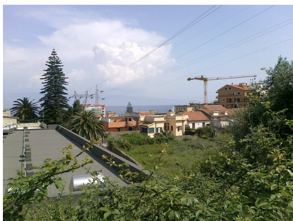
Figura 3.62 Area di cantiere a ridosso di via Marco Polo.
