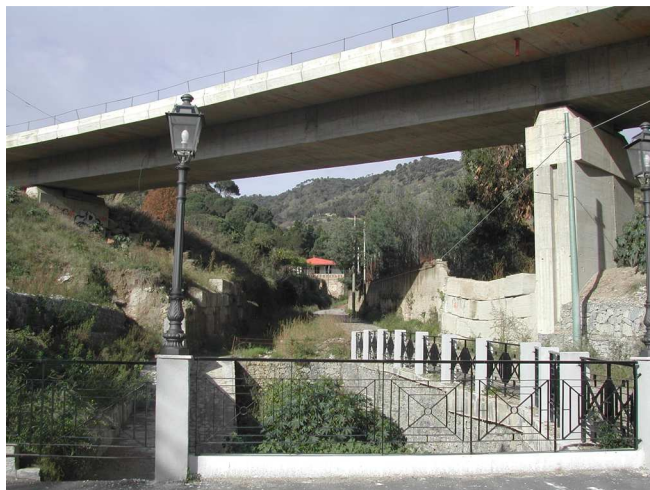
Figura 3.49 Viadotto stradale sulla fiumara.
