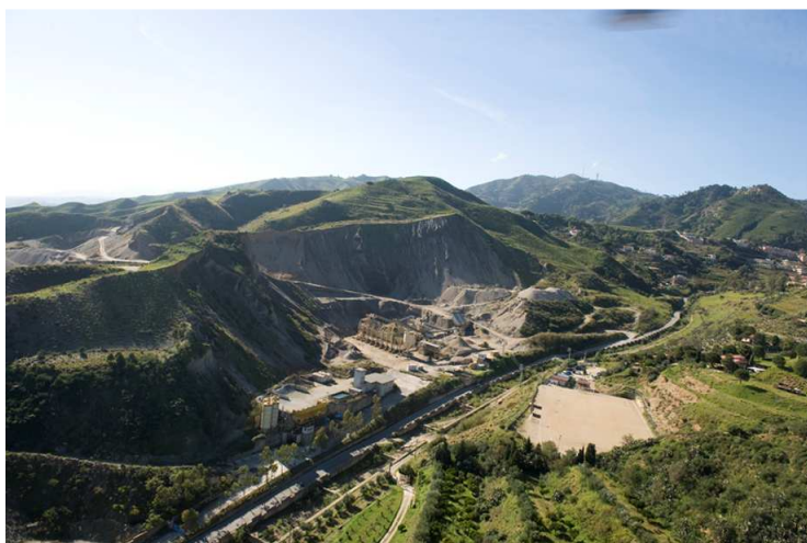
Figura 3.69 Foto aerea dell'area di impianto.
