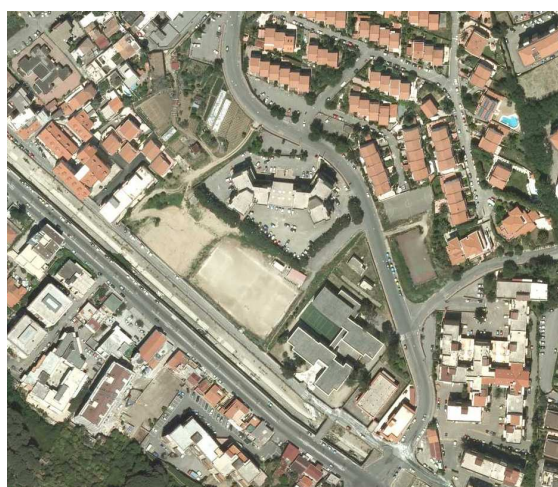
Figura 3.128 Foto aerea stazione Annunziata
