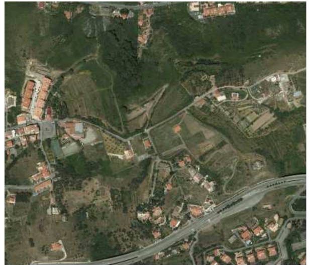
Figura 3.17 Foto aerea dell'area di cantiere.
