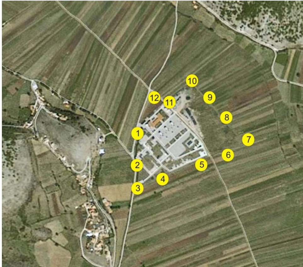
Figura H: Vista dei punti di misura eseguiti a confine dell'impianto Snam Rete Gas
