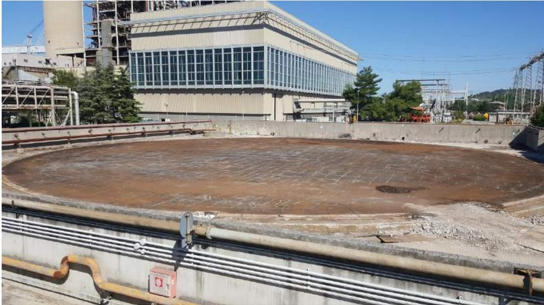
Figura 9: basamento serbatoio S3
