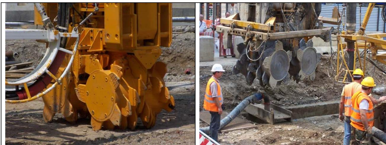
Figura 3.7 Idrofresa per scavo paratie di stazione
