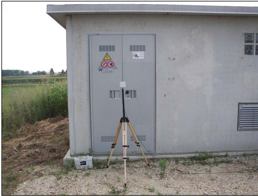
Figura 2.58 – Installazione su treppiede
