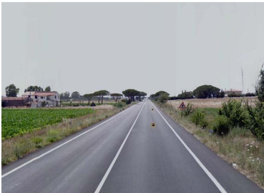
*Figura 13: tratto con sezione stradale ad 1 corsia per senso di marcia*
