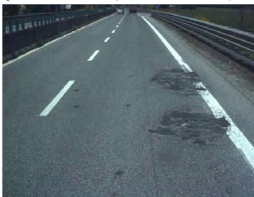
Figura 3 - Ammaloramenti localizzati (AL)
