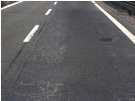
Figura 1 - Fessure a pelle di cocodrillo (FPM)
