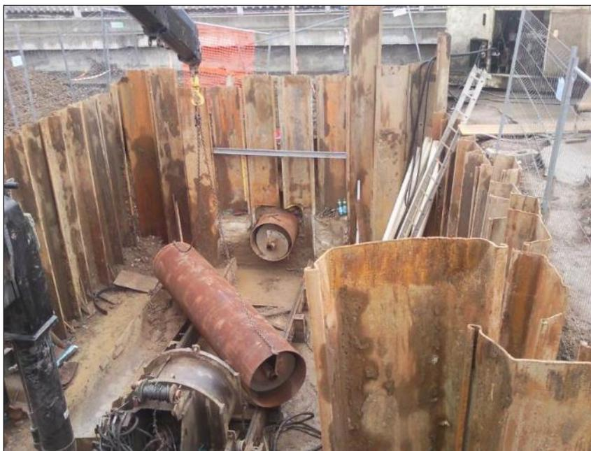
**Foto 8.2 – Buca di spinta per trivella spingitubo sostenuta da palancoato**
