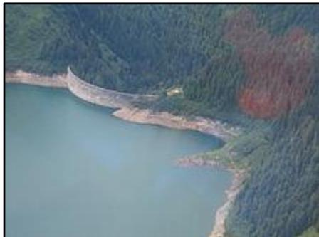
Il 23 gennaio 1929 la SEEA presentò un nuovo progetto, a firma dell'Ing. Vincenzo Ferniani, che prevedeva la realizzazione di una diga ad arco, avente le caratteristiche corrispondenti a quella poi realizzata, tipo Jorgensen, ad arco sottile (ad angolo quasi costante), con la volta ad inclinazione pari al 20%.
