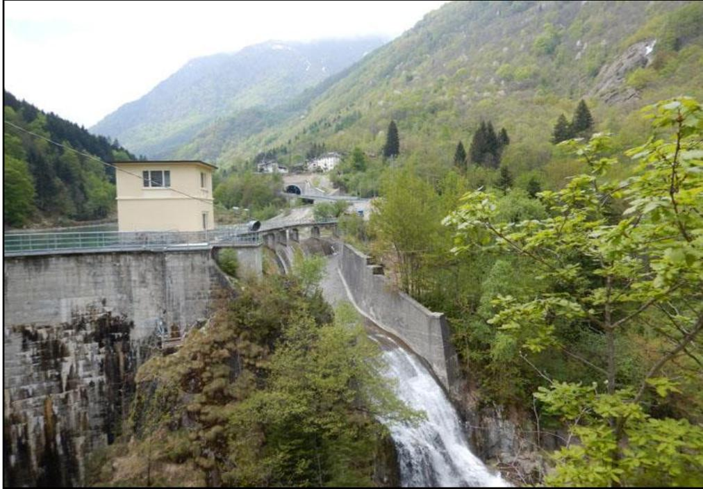
*Figura 7g Scarico di superficie esistente della diga. Vista da Sud*
