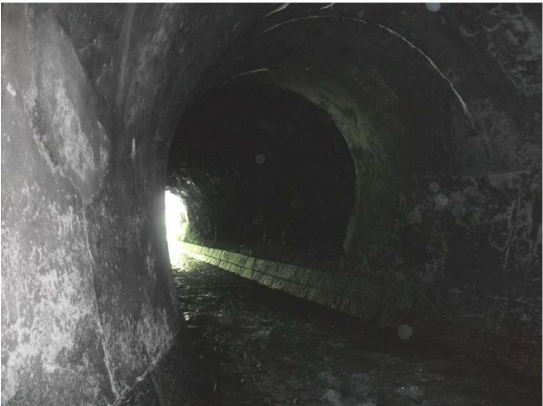
Figura 3 - Calotta rivestita dello scarico intermedio
