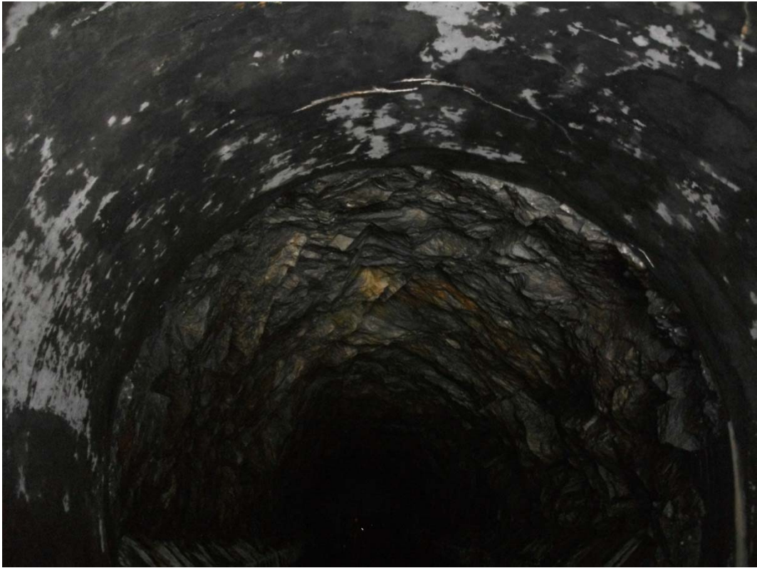
Figura 2 - Calotta non rivestita dello scarico intermedio
