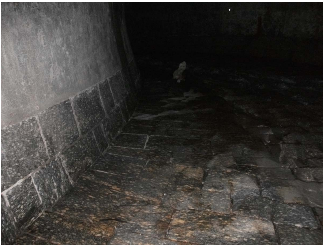
Figura 1 - Platea dello scarico intermedio
