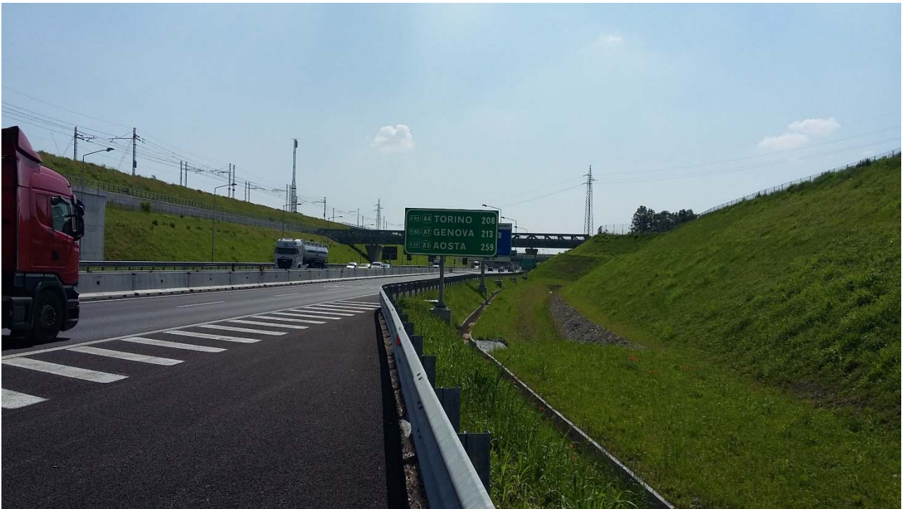
Tratto in trincea PK 5+000 lato Nord
