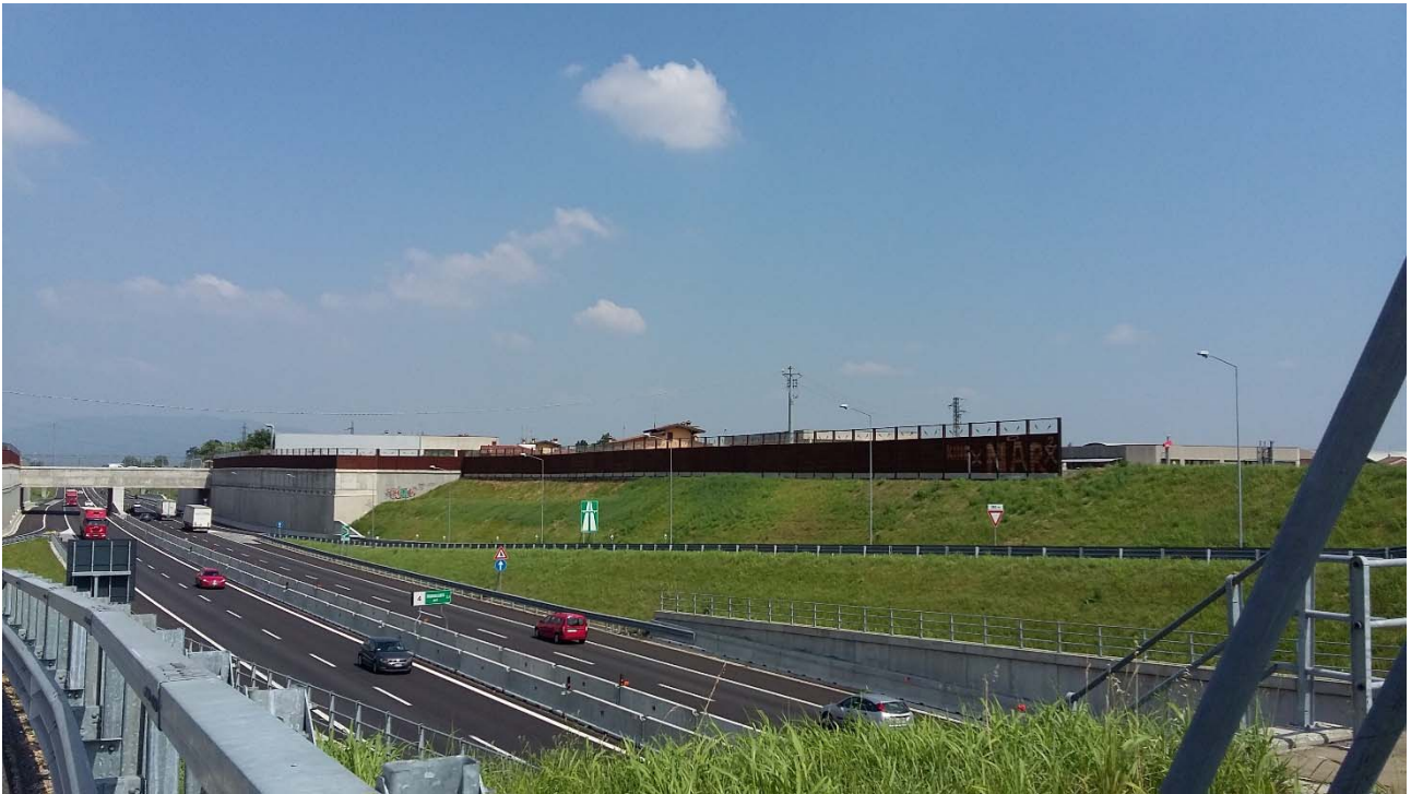
PK 4+110 lato Sud svincolo Travagliato Ovest
