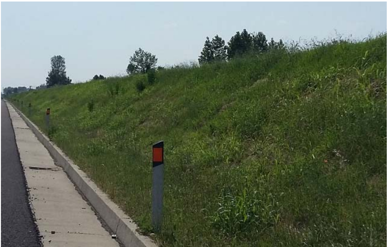
Scarpate trincea PK 16+800 lato Nord
