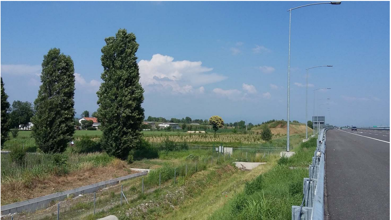
Piantumazioni duna DU001 PK 15+850 lato Nord
