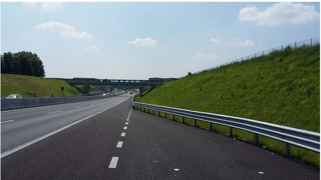
PK 3+400 lato Nord
