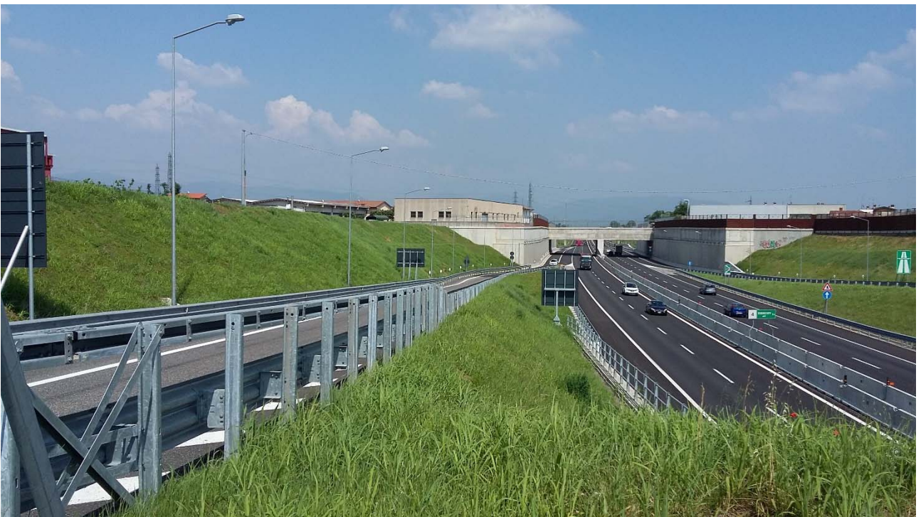
PK 4+110 lato Nord svincolo Travagliato Ovest
