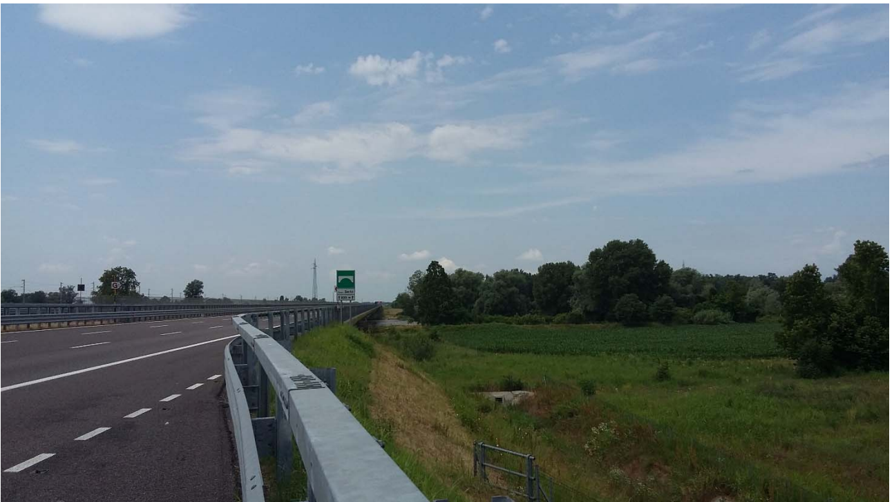
Viadotto Serio PK 32+070 lato Nord
