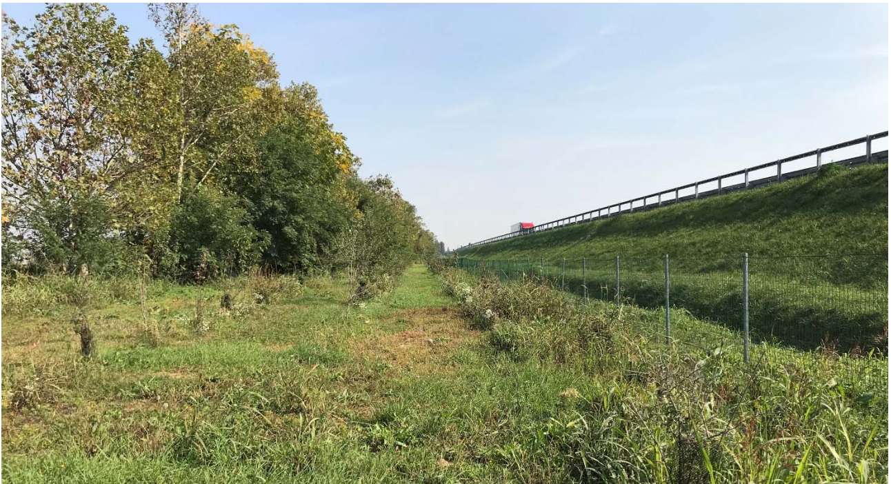
Scarpate idroseminate in rilevato
