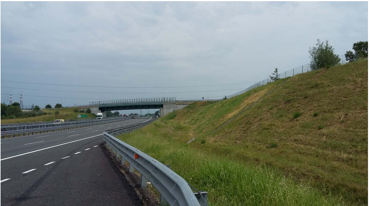
Trincea pk 51+100 lato Sud
