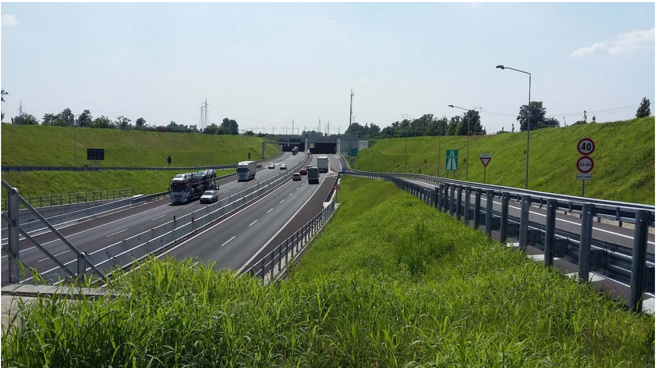
PK 4+110 lato Nord svincolo Travagliato Ovest
