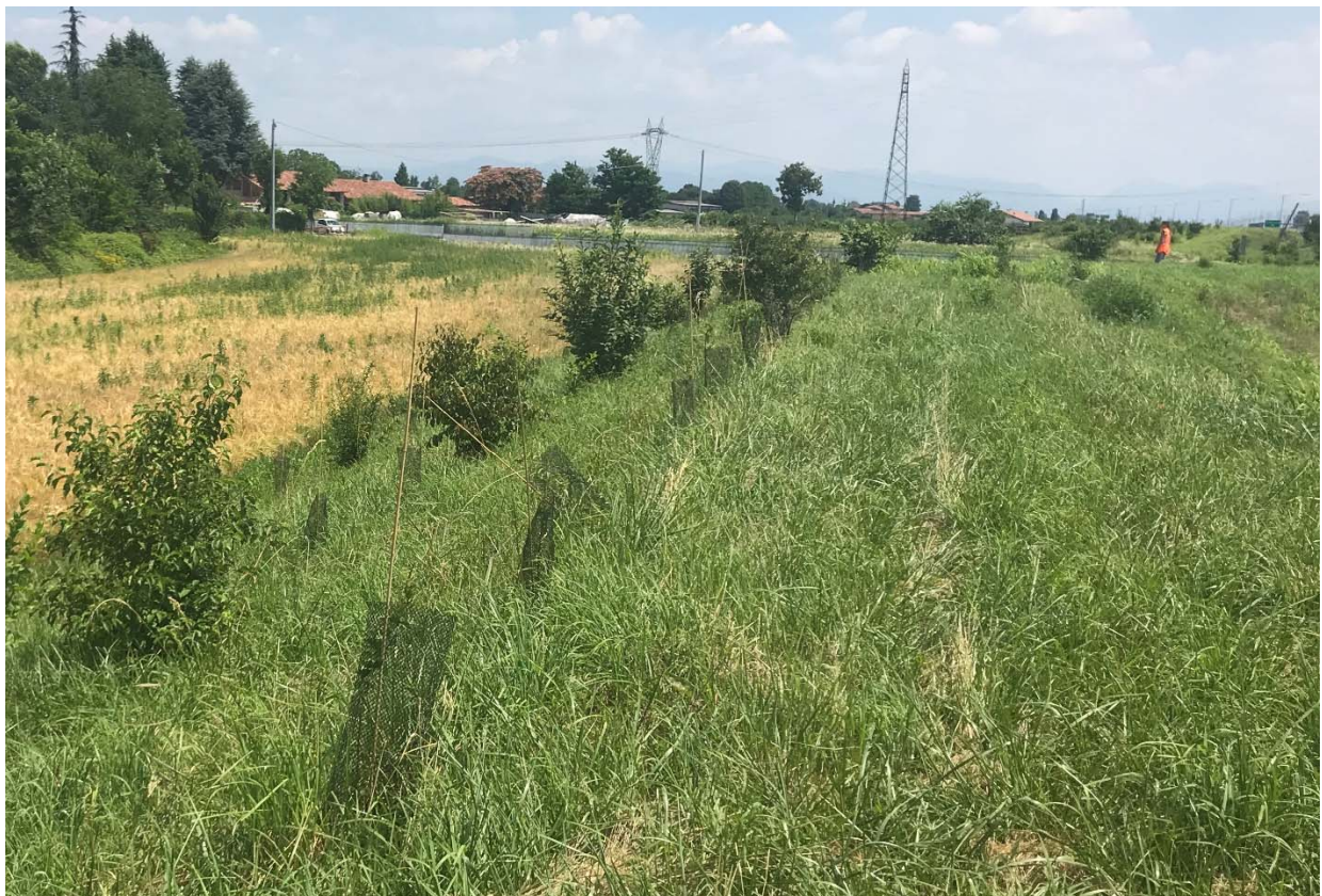
Duna DU001 COD. C1 L2-2 Sostituzione fallanze e sfalcio eseguito
