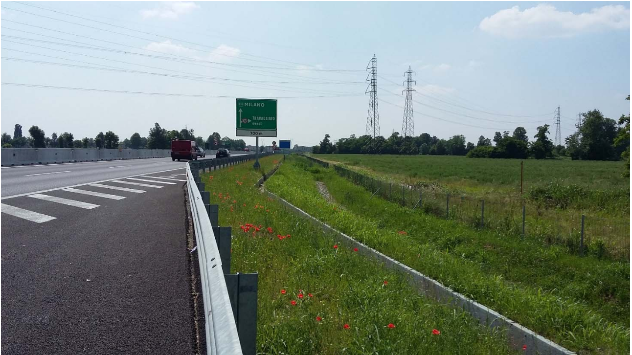
PK 2+850 lato Nord
