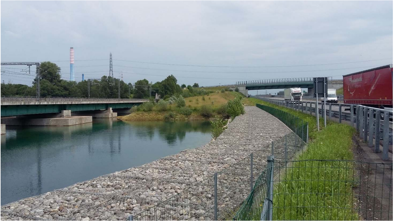
Cavalcavia pk 51+000 lato Nord
