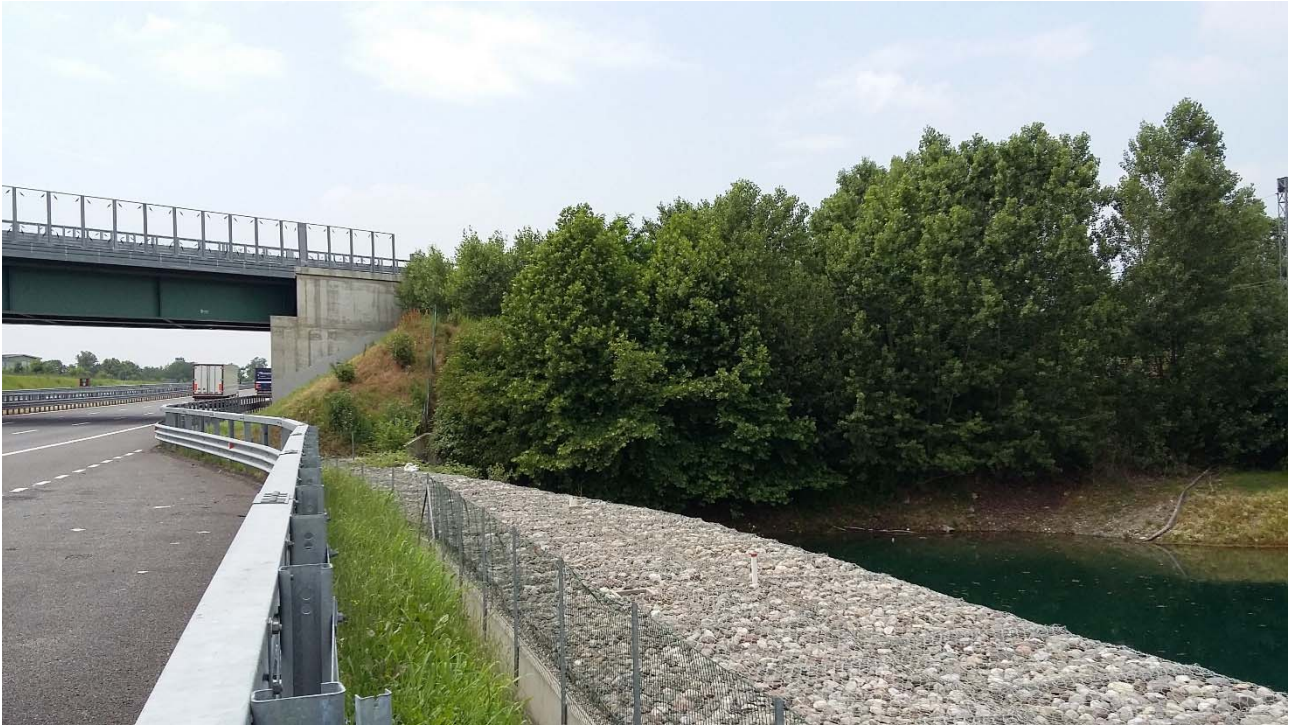
pk 51+200 lato Nord
