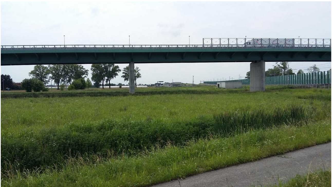
Galleria di Treviglio PK 40+803 lato Nord
