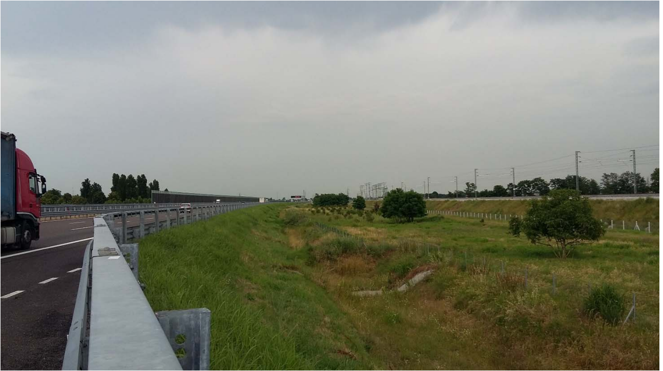
Rilevato area interposta PK 26+500 lato Sud
