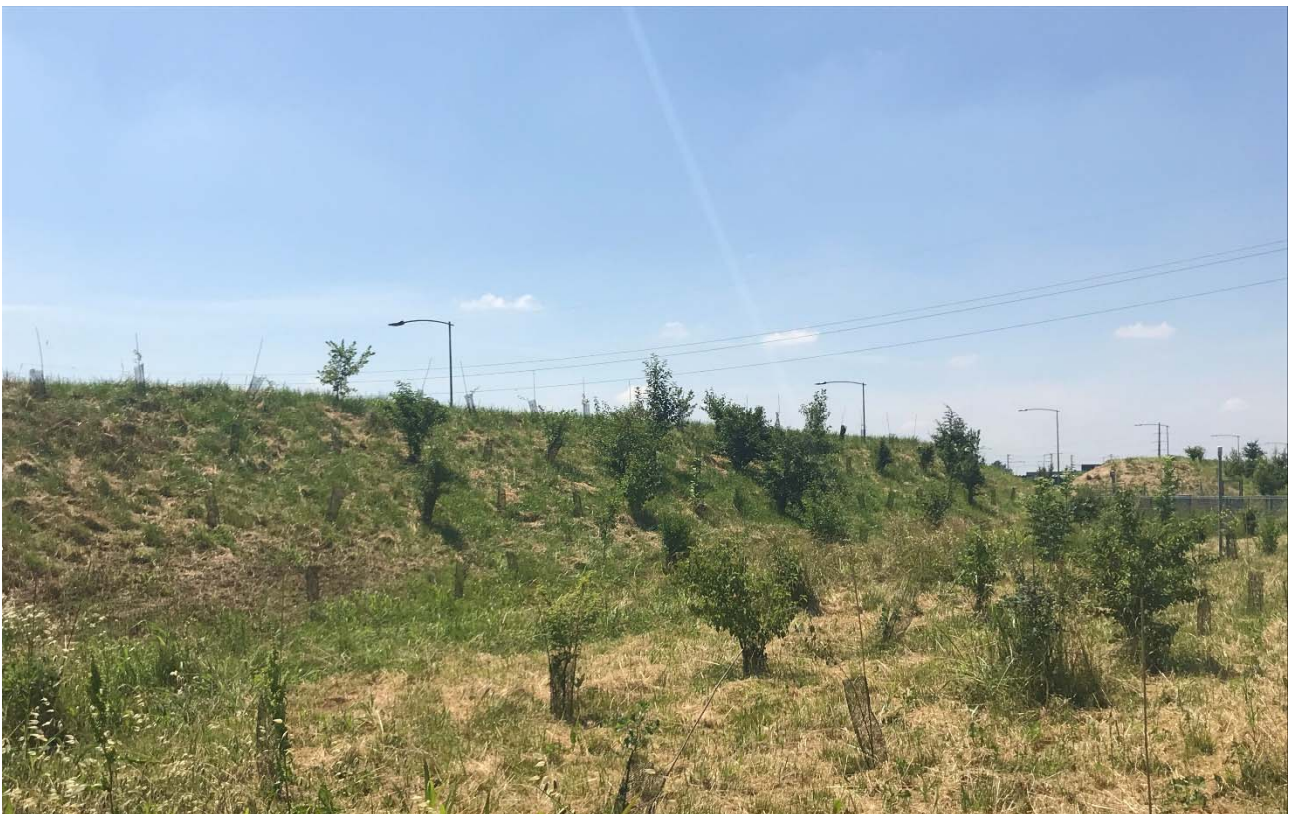
Duna DU001 COD. C1 L1-4 -Sostituzione fallanze e sfalcio eseguito
