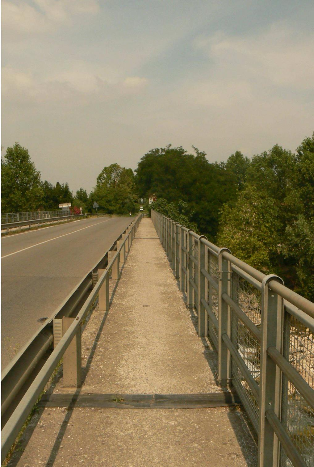
Foto 3 – particolare della passerella esistente sul lato sud ponte Oglio oggetto di ampliamento
