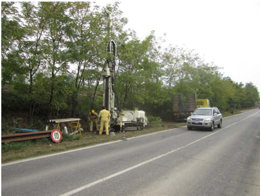
Esecuzione del sondaggio a carotaggio continuo
