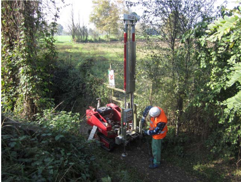
Esecuzione prove penetrometriche dinamiche SCPT (lato nord P3)
