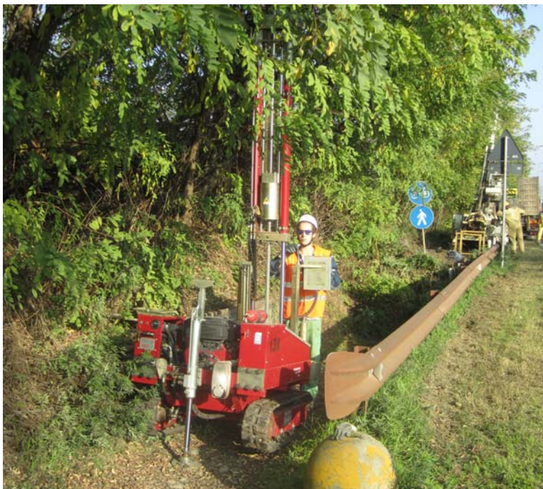
Esecuzione prove penetrometriche dinamiche SCPT (lato sud P2)
