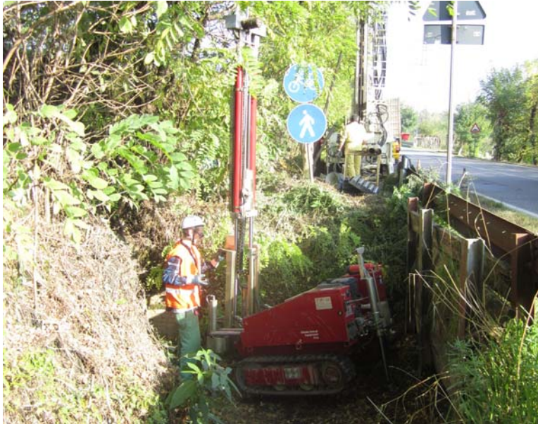
Esecuzione prove penetrometriche dinamiche SCPT (lato sud – P1)
