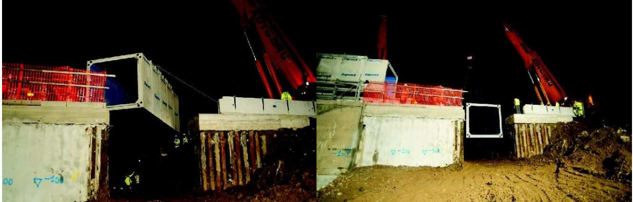
Riferimento: posizionamento moduli scatolari
