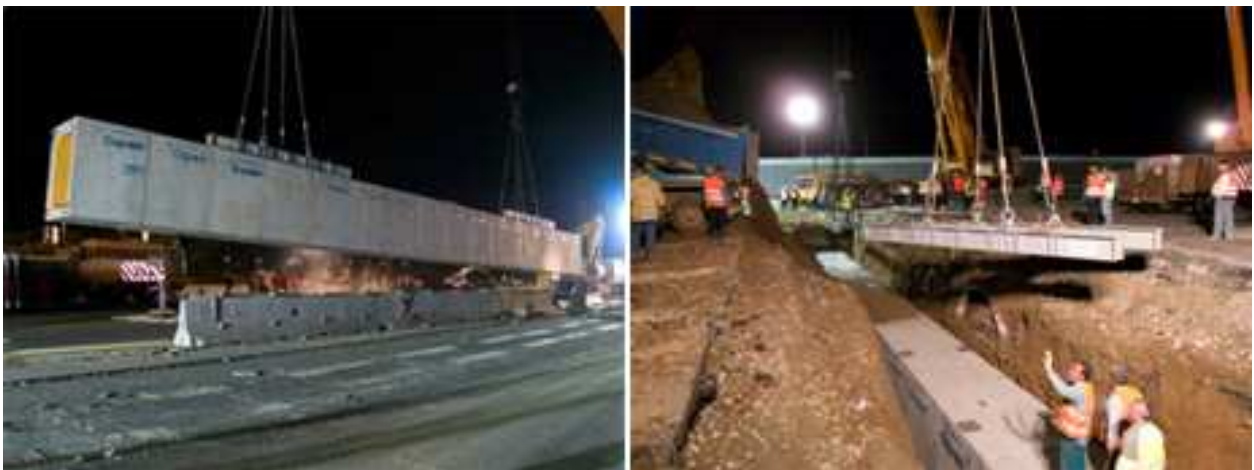
Riferimento: posizionamento moduli scatolari
