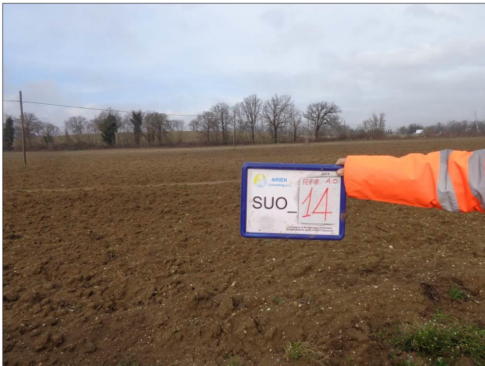
Cantiere base e area di stoccaggio sv. Matelica Sud
